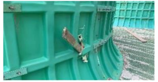
Şekil 3.14. Jeotermal Enerji Santralinde Hasarlı Soğutma Bacası
