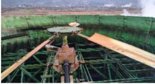
Şekil 3.14. Jeotermal Enerji Santralinde Hasarlı Soğutma Bacası
