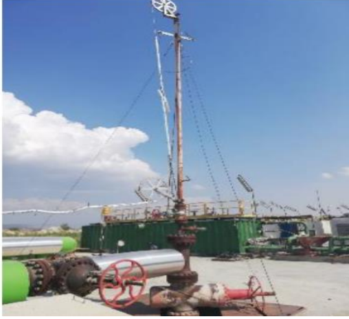
Şekil 3.16. Jeotermal Enerji Santralinde Tıkalı Kuyu Açma Çalışmaları
