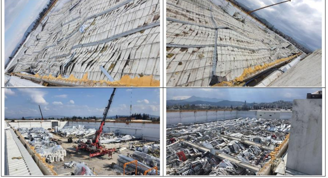
Şekil 3.8. Güneş Enerji Santralinde Deprem Sonucu Oluşan Yıkım 1
