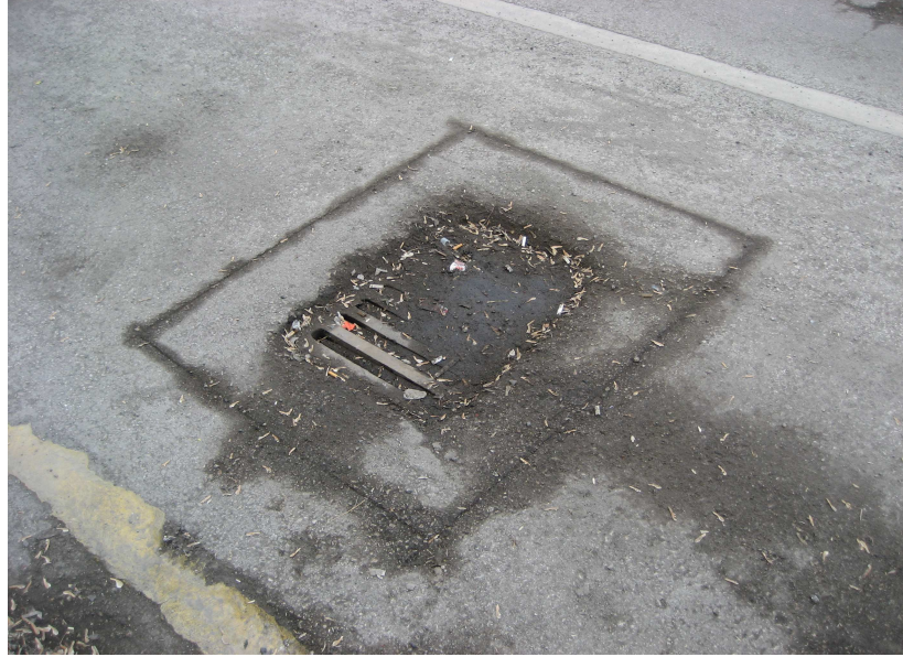
Şekil 4.5. Mevcut yolda sürüntü ve döküntü maddeleriyle tıkanma
