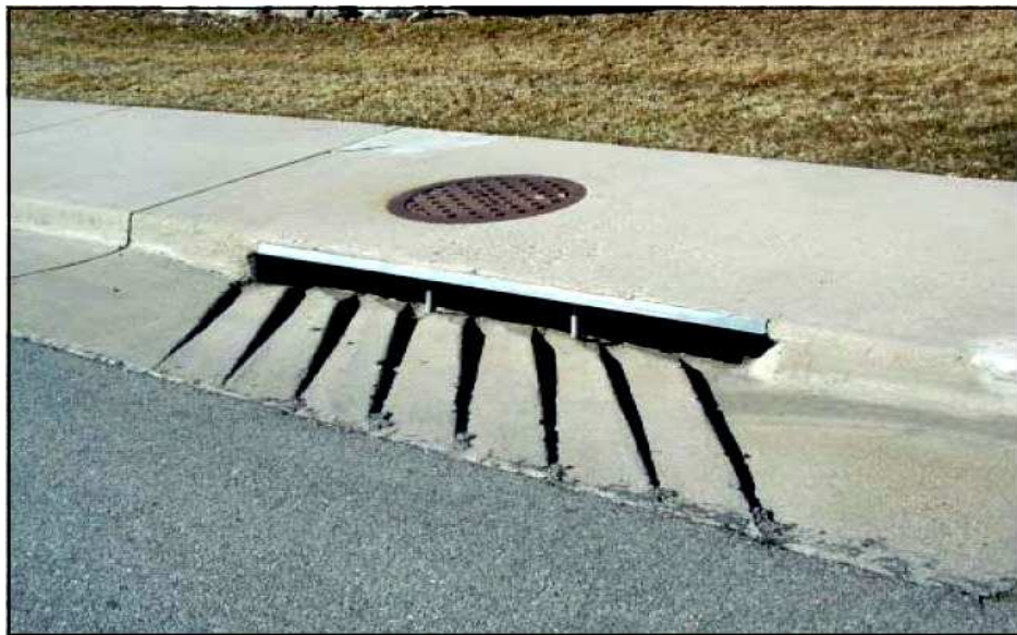
Şekil 1.18. Bordürde bırakılan saptırcılı giriş
