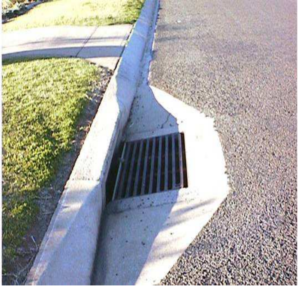
Şekil 1.19. Ark ve bordür girişinin birlikte kullanıldığı birleşik giriş
