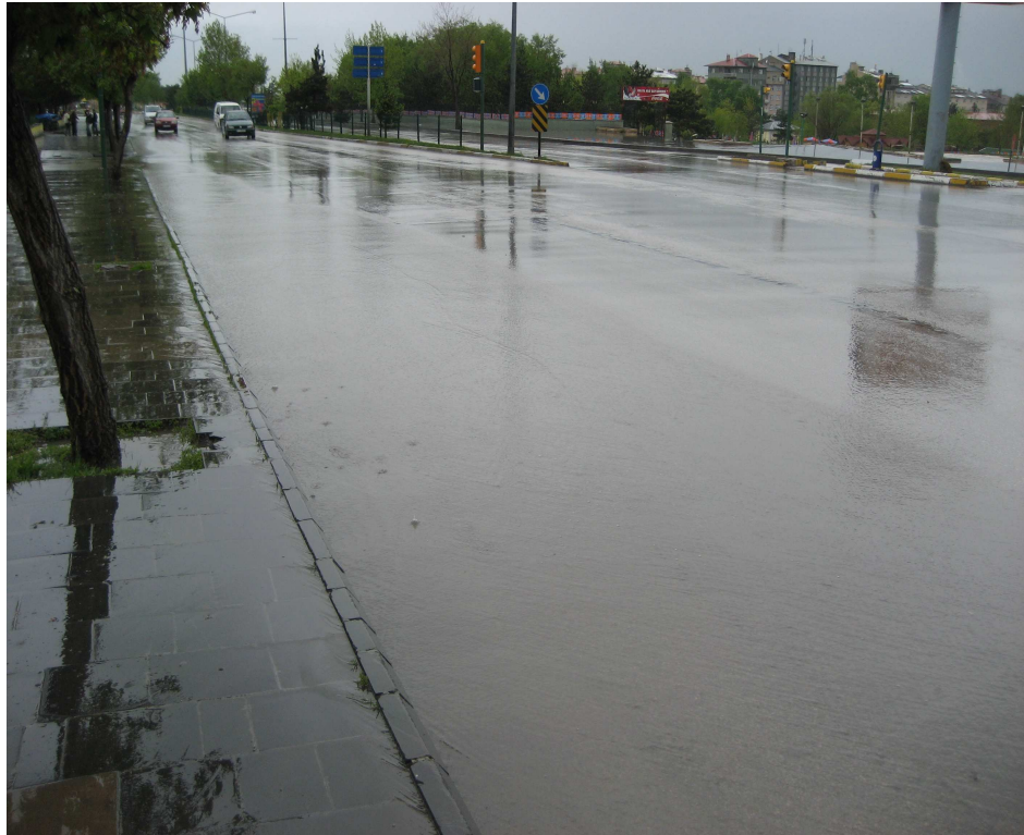
Şekil 4.1. Üniversite-Havuzbaşı arası yolda suyun fazla yayılması
