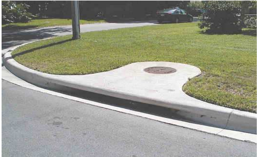
Şekil 1.15. Kentiçi yollara yerleştirilen bordür girişi
