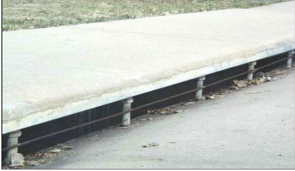
Şekil 1.17. Bordürde bırakılan çukurlaştırılmış giriş
