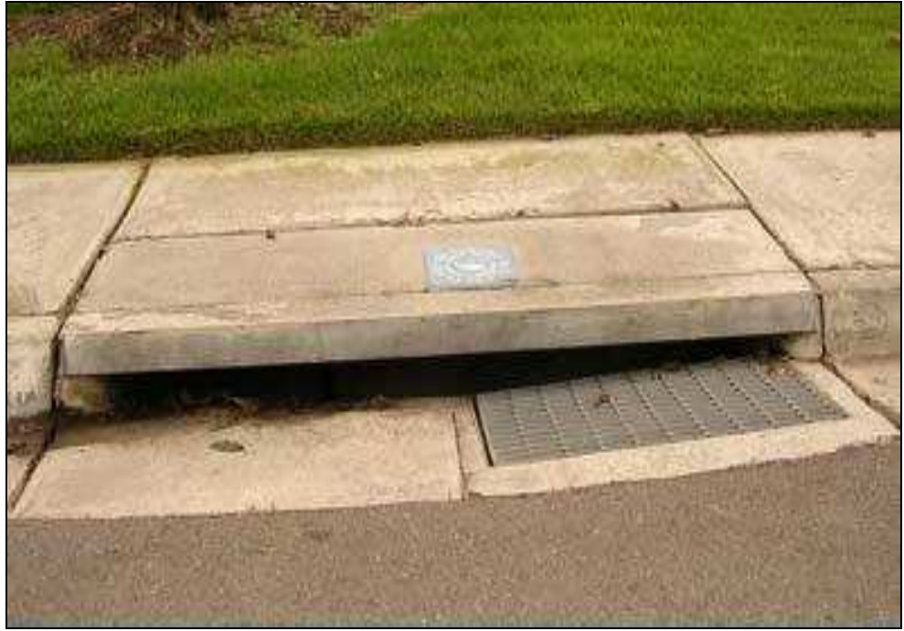
Şekil 1.21. Izgaranın bordürün mansap tarafına yerleştirilmesi
