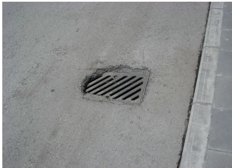
Şekil 4.6. Mevcut yollara yeni yerleştirilen ızgara
