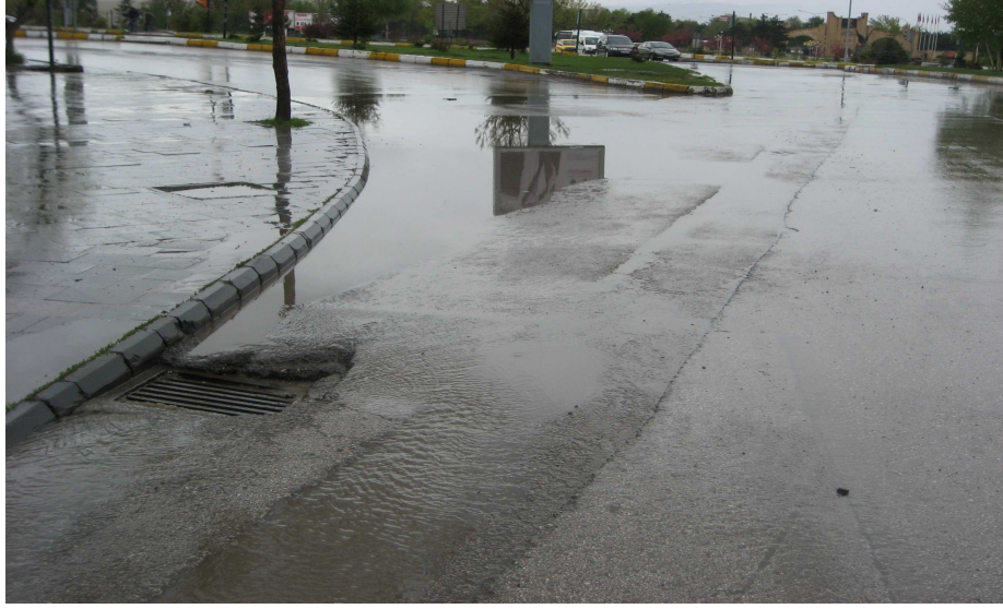
Şekil 4.3. Üniversite-Havuzbaşı arası yolda bordüre dik olarak yerleştirilmiş ızgara
