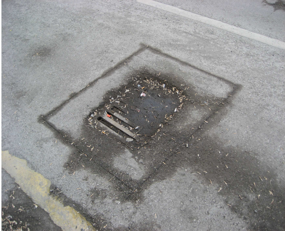
Şekil 1.13. Izgaralı girişin döküntü ve sürüntü maddeleri ile tıkanması
