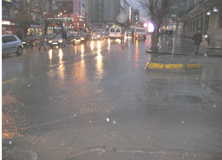
Şekil 1.2. Yağış sonrasında yol yüzeyinde oluşan su birikintileri
