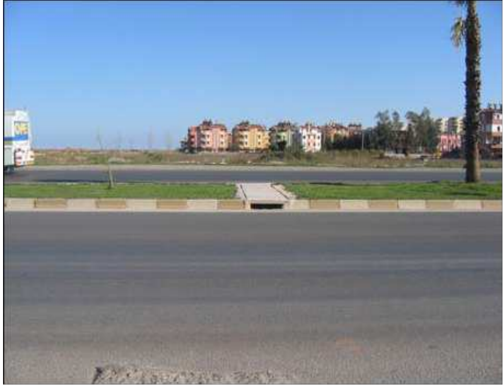
Şekil 1.16. Bordürde bırakılan düz giriş
