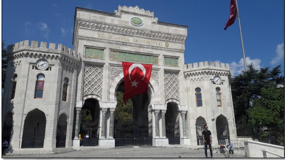
Fotoğraf 3.37. Güzel ve görkemli bir görünüme sahip olan İstanbul Üniversitesi Kapısı, Sultan Abdülaziz tarafından oryantalist üslupta inşa ettirilmiştir.
