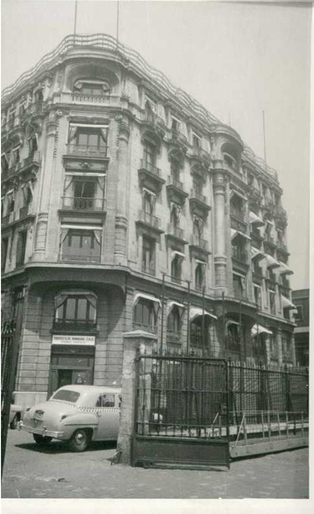
F.19 Denizcilik Bankası Türk Anonim Şirketi'nin Genel Müdürlük Binası (İstanbul Büyükşehir Belediyesi Atatürk Kitaplığı)
