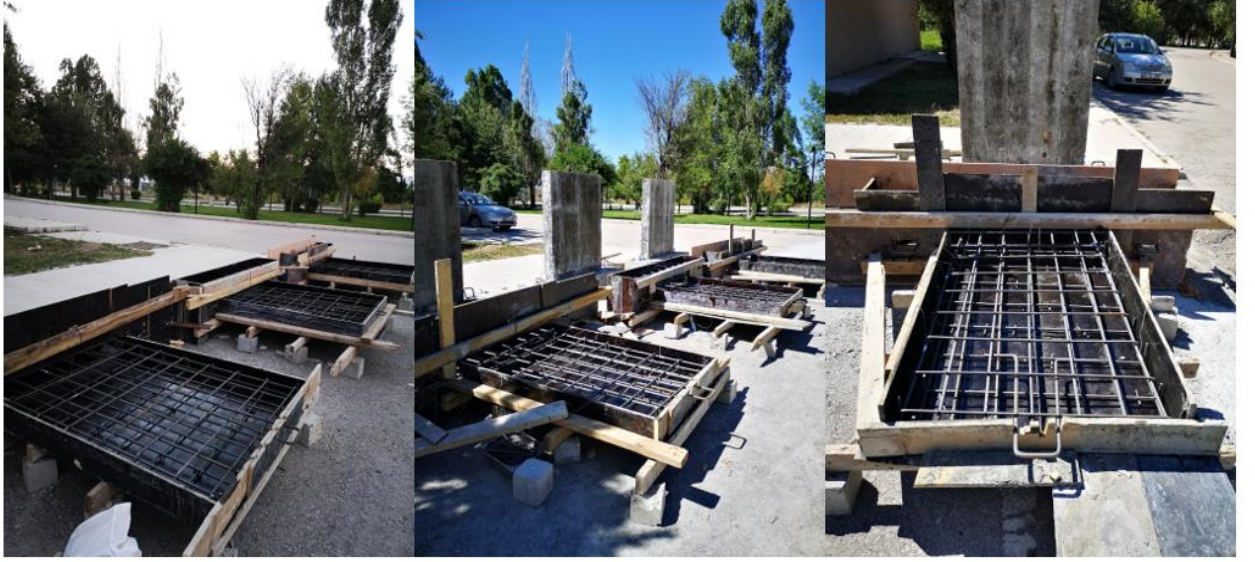
Şekil 34. Numunelerin donatı ve kalıp işlemlerinin bitmiş hali.
