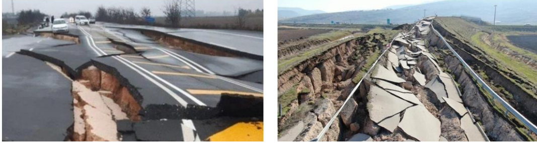
Şekil 4. 6 Şubat 2022 depremlerinde kullanılamaz hale gelen ulaşım üst yapıları (Bakırcı ve Aydoğdu 2023)
