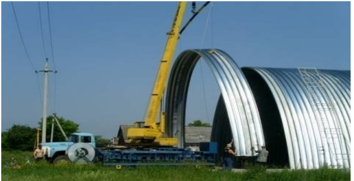
Şekil 2.34. Galvanizli sac ile üretilmiş prefabrik yapının montaj işlemi
