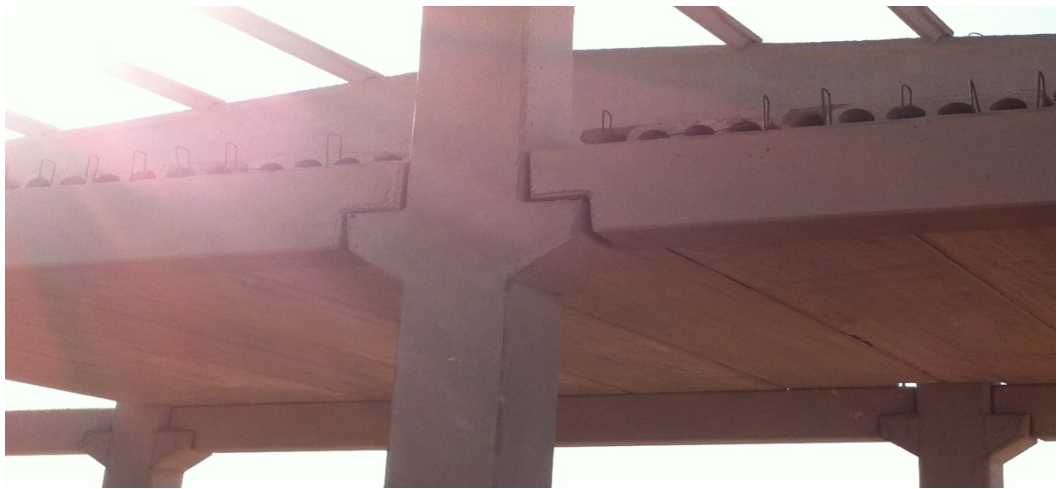
Şekil 2.18. Prefabrik kirişin kolon döşeme birleşimi
