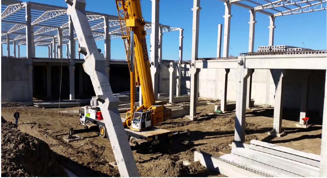
Şekil 2.15. Prefabrik kolonların yerleştirilmesi
