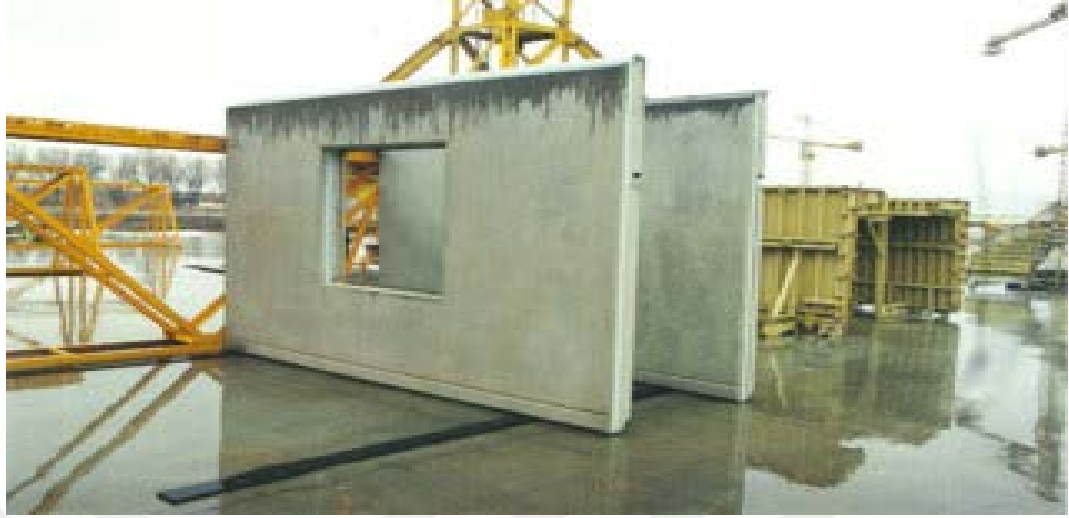
Şekil 2.27. Prefabrik duvarların nakliyesi
