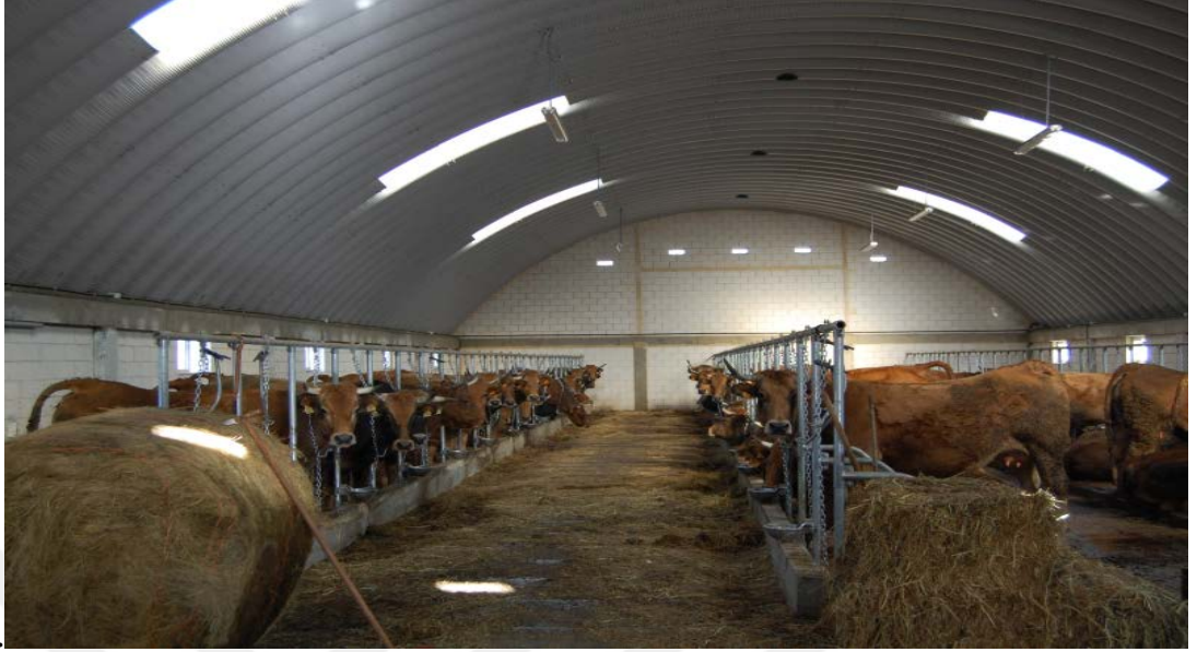
Şekil 2.33. Galvanizli sac ile yapılmış prefabrik ahırlardan bir görünüş
