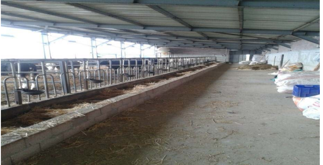
Şekil 2.4. Yemlik ve yemlik yolu görünümü
