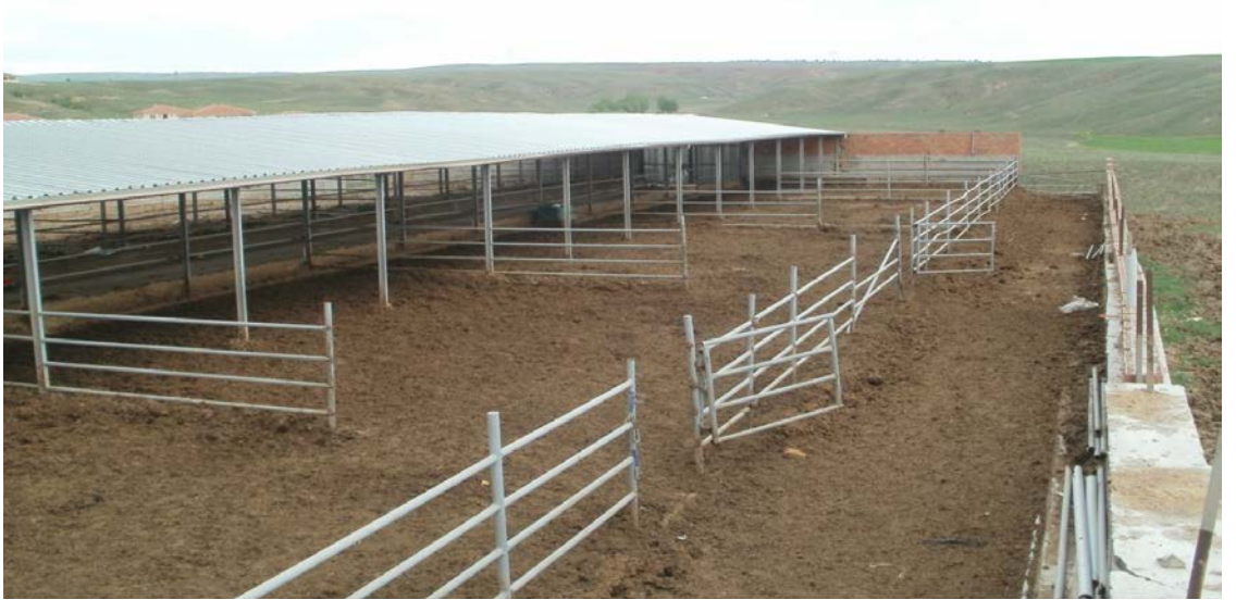
Şekil 2.3. Serbest sistem sığır barınağının gezinti alanından bir görünüş
