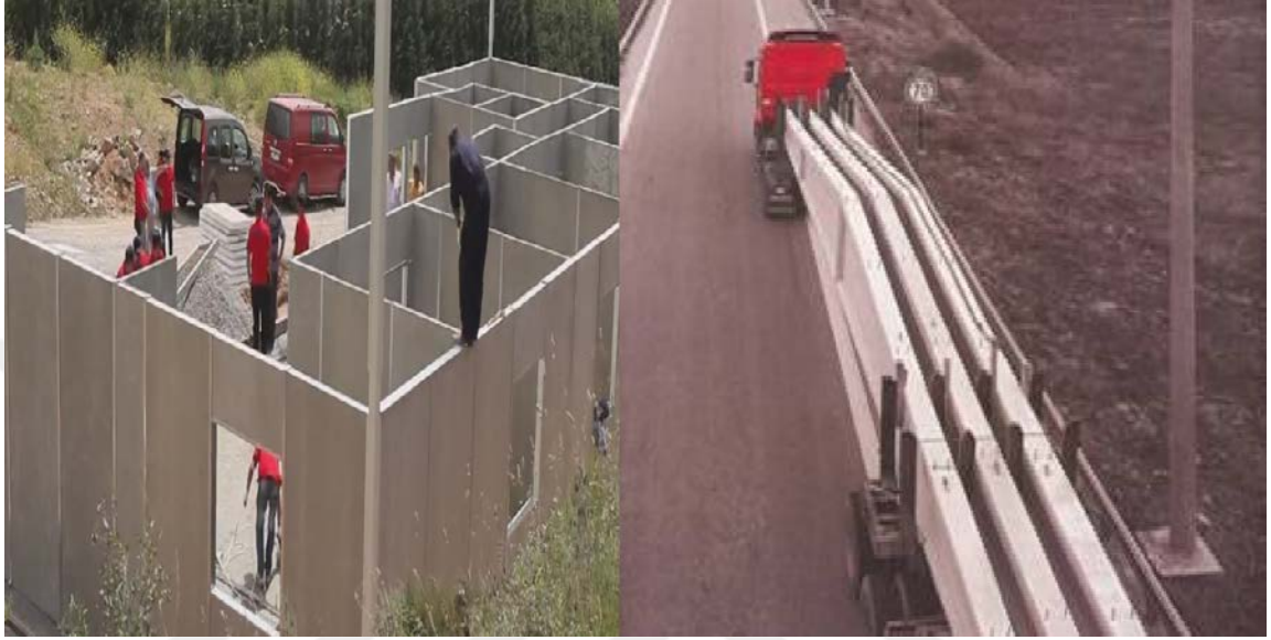
řekil 2.28. Prefabrik yapı elemanlarında taşıma ve montaj
