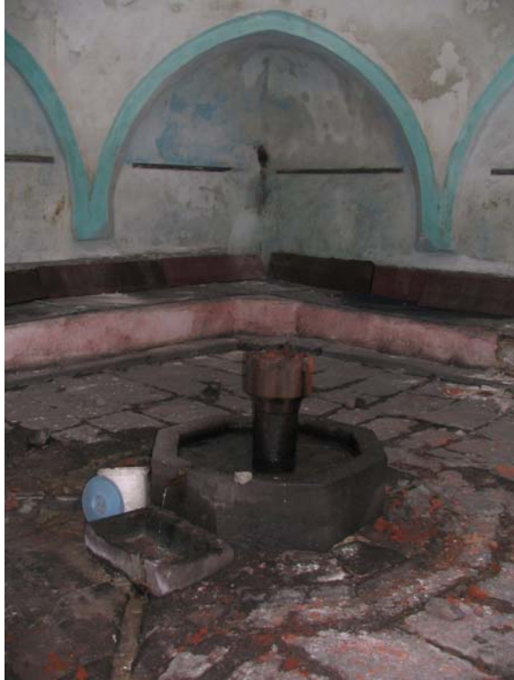
Resim 4.140: Hamamın Onarımdan Önceki Soyunmalık Kısmı
