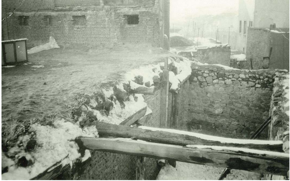
Resim 4.122: Hamamın Onarımdan Önceki Üst Örtüsü
