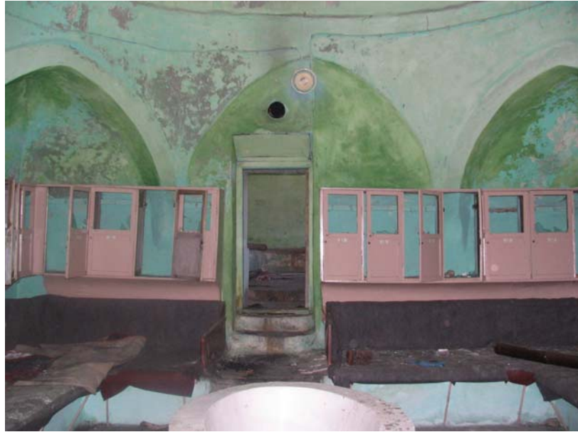
Resim 4.111: Hamamın Onarımdan Önceki Soyunmalık Kısmı
