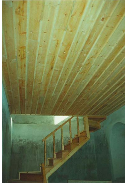
Resim 4.60e: Hamamın Onarımdan Önceki ve Onarımdan Sonraki Görüntüleri
