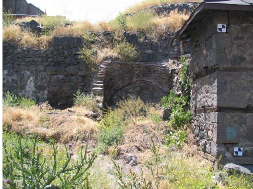
Resim 4.138: Hamamın Onarımdan Önceki Beden Duvarları
