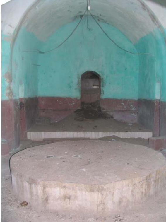
Resim 4.113: Hamamın Onarımdan Önceki Sıcaklık Kısmı
