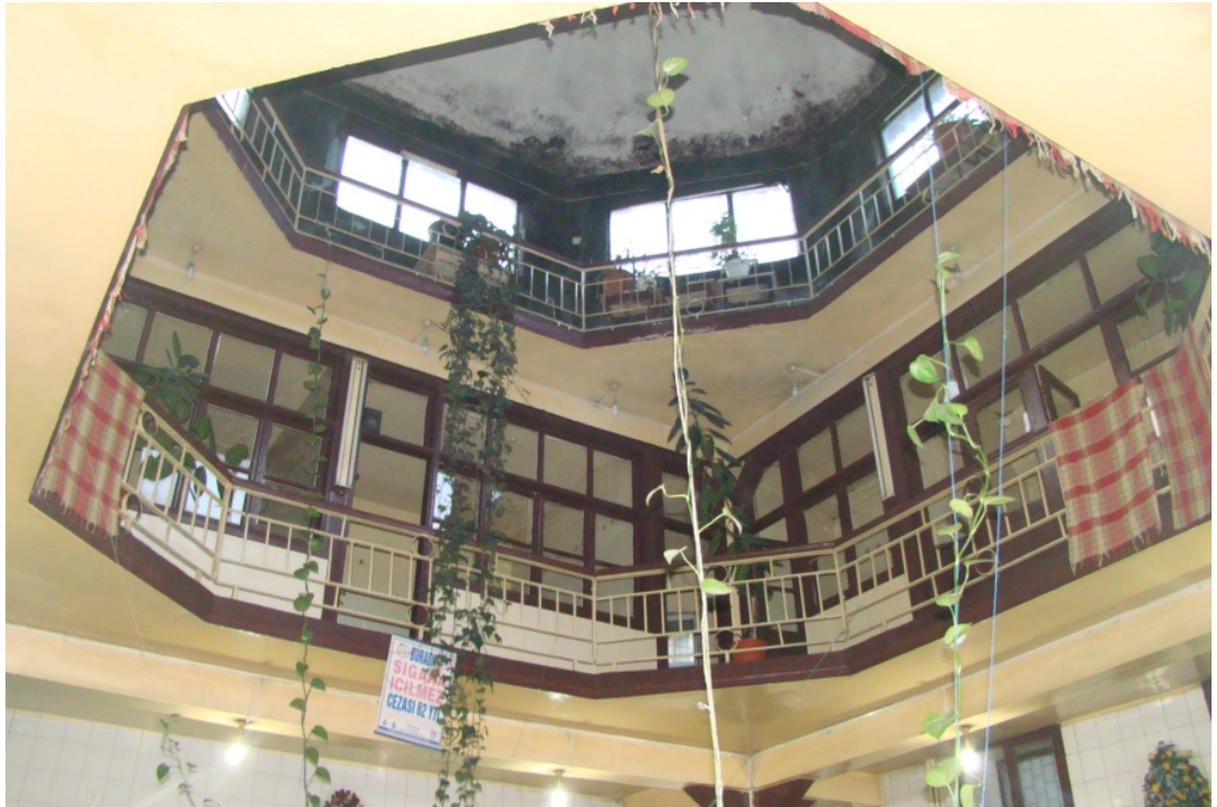
Resim 4.43a: Soyunmalık Kısmı Katlarından Görüntü
