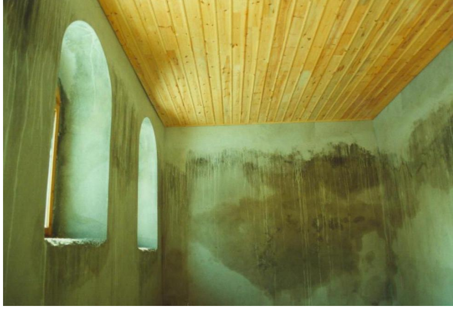
Resim 4.60d: Hamamın Onarımdan Önceki ve Onarımdan Sonraki Görüntüleri
