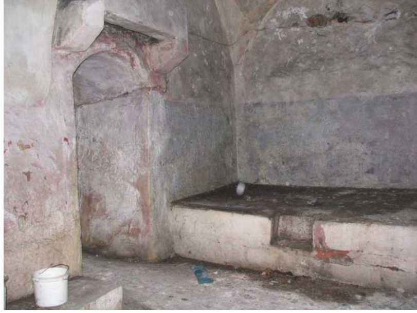
Resim 4.141: Hamamın Onarımdan Önceki Ilıklık Kısmı
