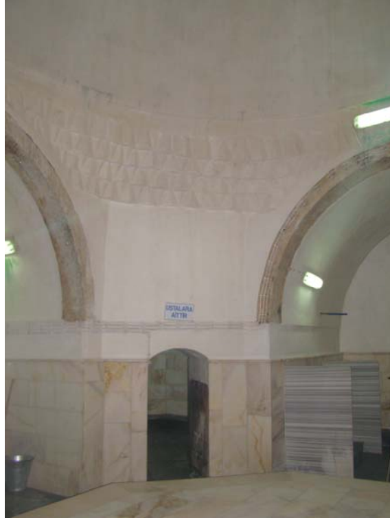
Resim 4.78: Sıcaklık Kubbesine Geçişte Kullanılan Mukarnas Süsleme
