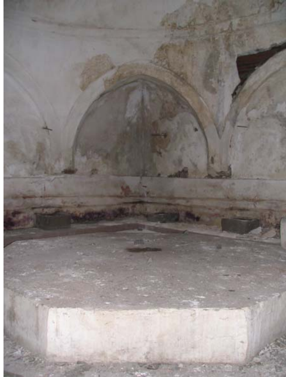
Resim 4.142a: Hamamın Onarımdan Önceki Sıcaklık Kısmı
