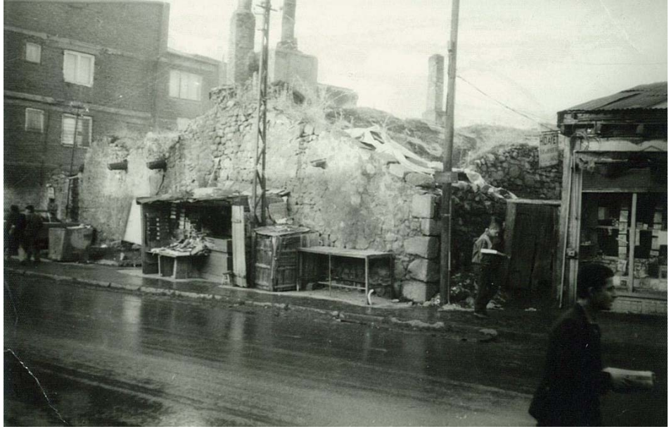
Resim 4.121: Hamamın Onarımdan Önceki Cephe K1sm1
