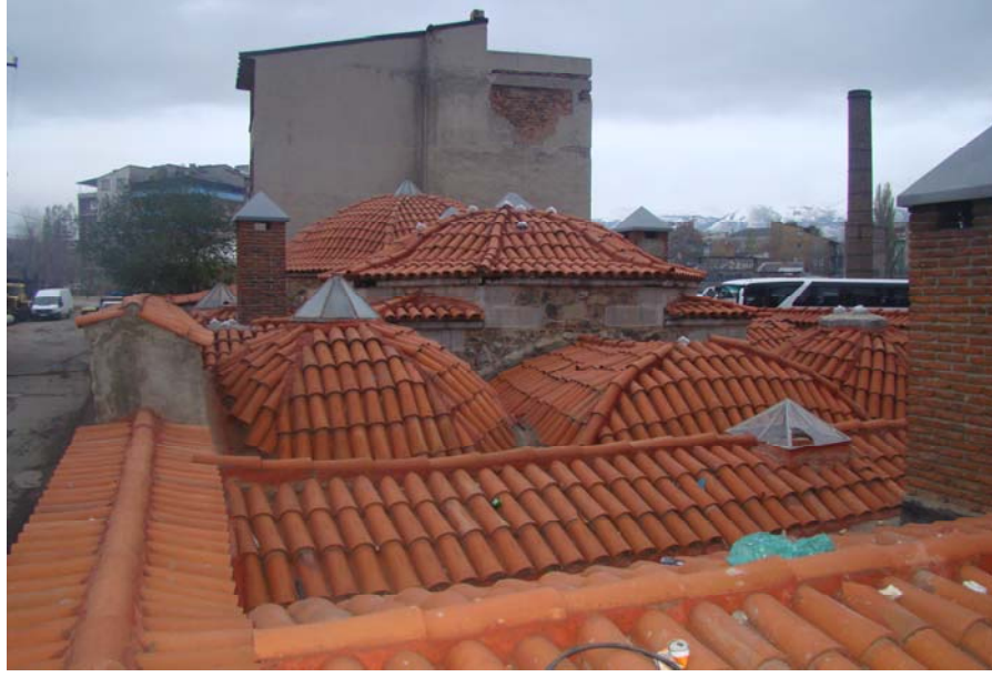
Resim 4.108b: Hamamın Onarımdan Önceki ve Onarımdan Sonraki Görüntüsü
