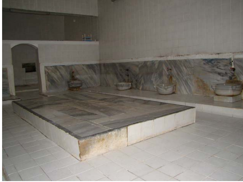
Resim 4.47d: Bayanlar Kısmı Sıcaklık Bölümü
