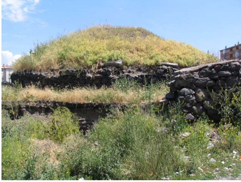
Resim 4.139: Hamamın Onarımdan Önceki Üst Örtüsü
