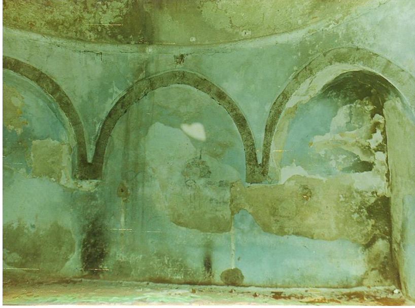
Resim 4.60b: Hamamın Onarımdan Önceki ve Onarımdan Sonraki Görüntüleri
