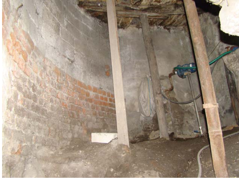
Resim 4.117: Hamamın Onarımdan Önceki Su Deposu
