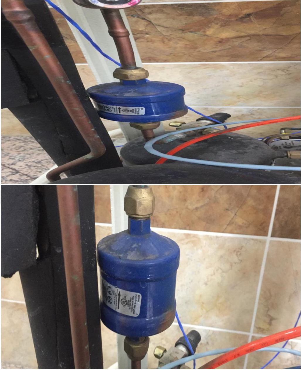
Şekil 44. Isı pompası sisteminde kullanılan filtre dryer (kurutucu) fotoğrafları.
