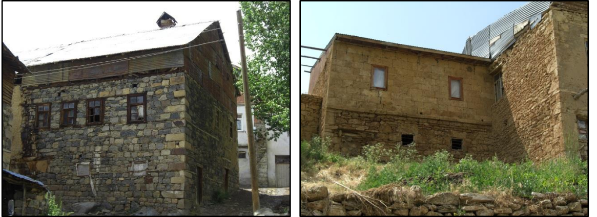
Fotoğraf 2.18. Araştırma Sahasında Taş Malzeme Kullanılarak İnşa Edilmiş Konutlar Oldukça Yaygındır. Solda Yoncalı Köyünde Koyu Renkli (granotoyid) Kayaçlardan İnşa Edilmiş Bir Ev, Sağda İse Yaylapınar Köyünde Kireçtaşı Ve Traverten Kullanılarak Yapılmış Bir Konut.
