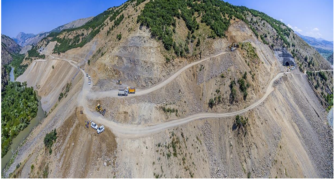
Fotoğraf 3.4. Yedisu- Kiğı İlçe Merkezleri Arasında İnşası Devam Eden Tünelden Görünüm (Kaynak: http://www.ozaltin.com.tr Erişim:18.08.2019).
