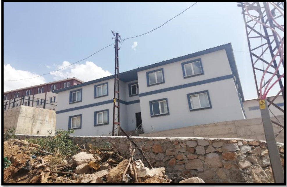
Fotoğraf 2.2. Yedisu İlçe Merkezi'nde Yer Alan Öğretmenevinden Görünüm.
