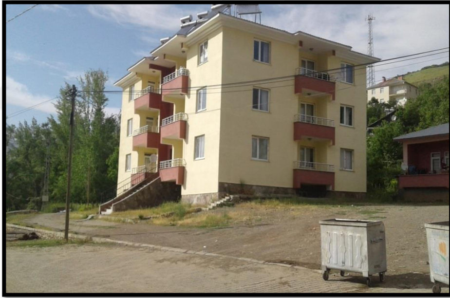
Fotoğraf 2.14. İlçe Merkezinde Son Yıllarda Çok Katlı Modern Binalar Yapılmaktadır.
