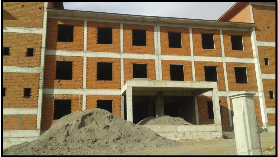
Fotoğraf 2.1. Merkez Mahallesinde Yapım Aşamasında Olan Ortaöğretim Pansiyonu.
