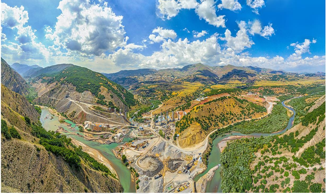
Fotoğraf 3.5. Yedisu-Kiğı İlçe Merkezleri Arasında Yapımı Devam Eden Köprü (Kaynak: http://www.ozaltin.com.tr Erişim:18.08.2019)
