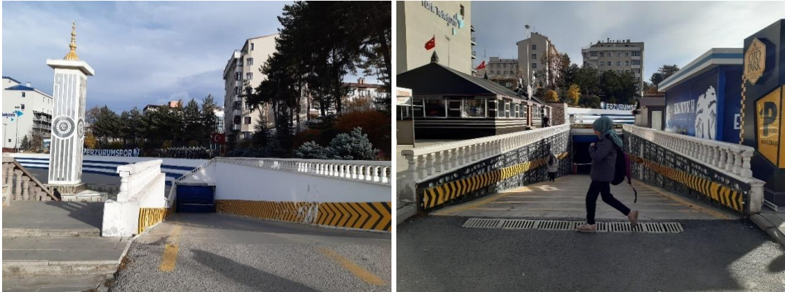
Şekil 134. Kent Meydanında bulunan otopark giriş çıkışları
