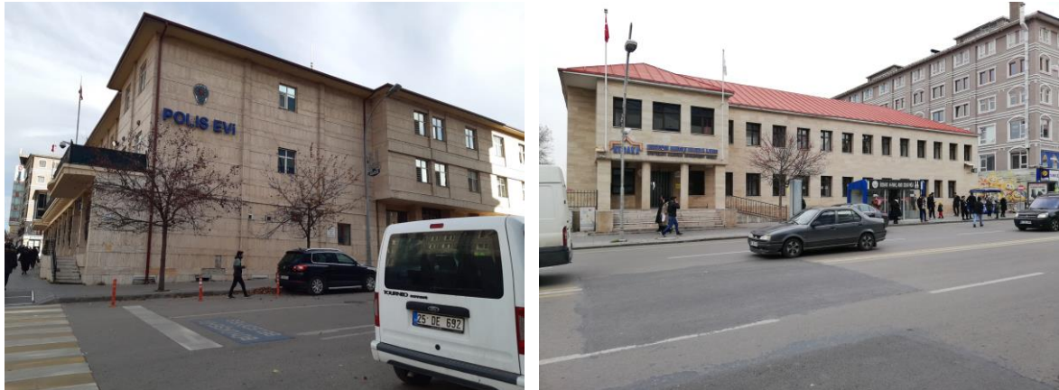
Şekil 66. Polisevi (sol) ve KUDAKA (sağ) binası
