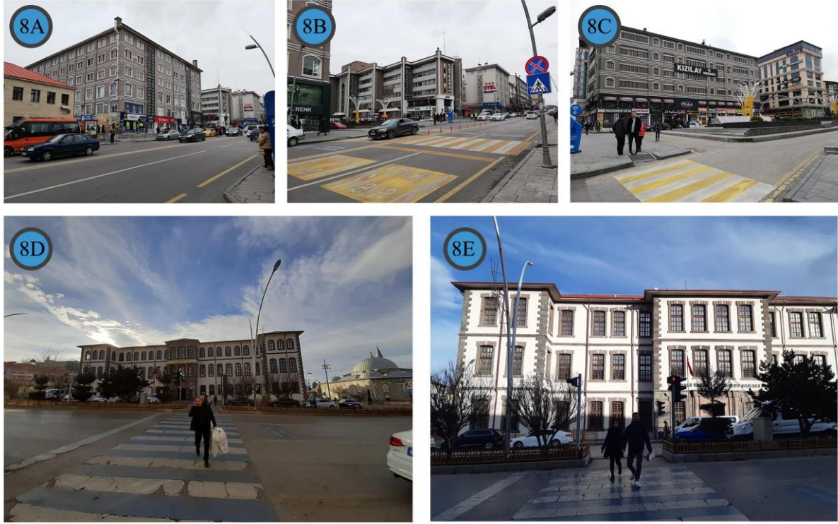
Şekil 65. Cephe uyumunun sağlandığı yapılar
