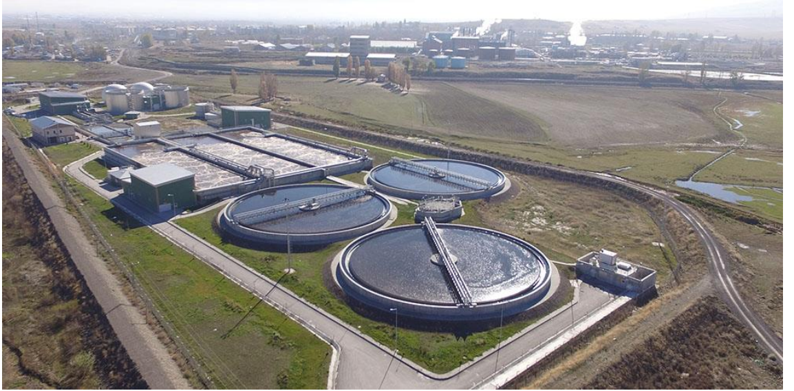
Şekil 3.4. Erzurum kentsel atık su arıtma tesisi ( http://www.eski.gov.tr/atesis/ 22.06.2019)
