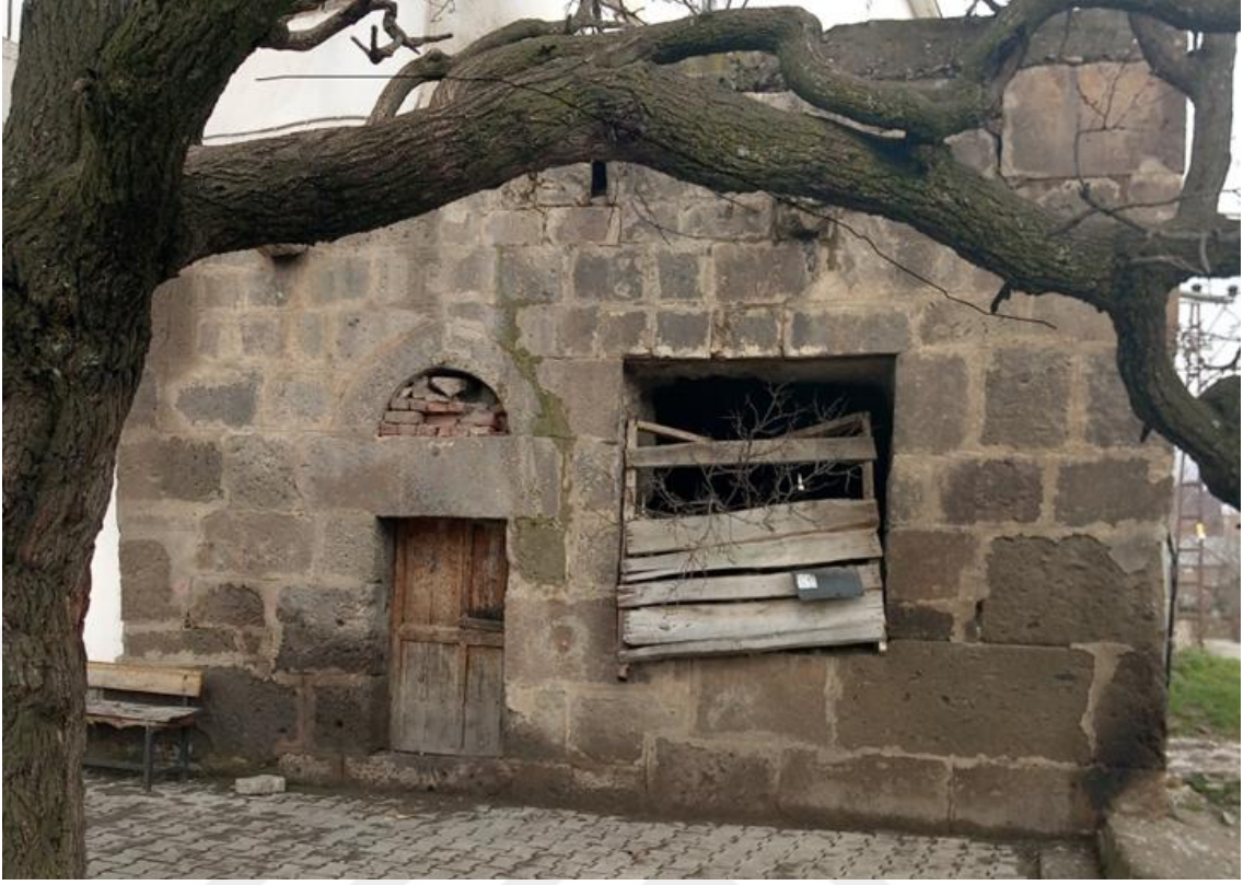
Fotoğraf 3.4. Adaklı Kilisesi, Merkez Mahallesi’nde bulunmaktadır.
