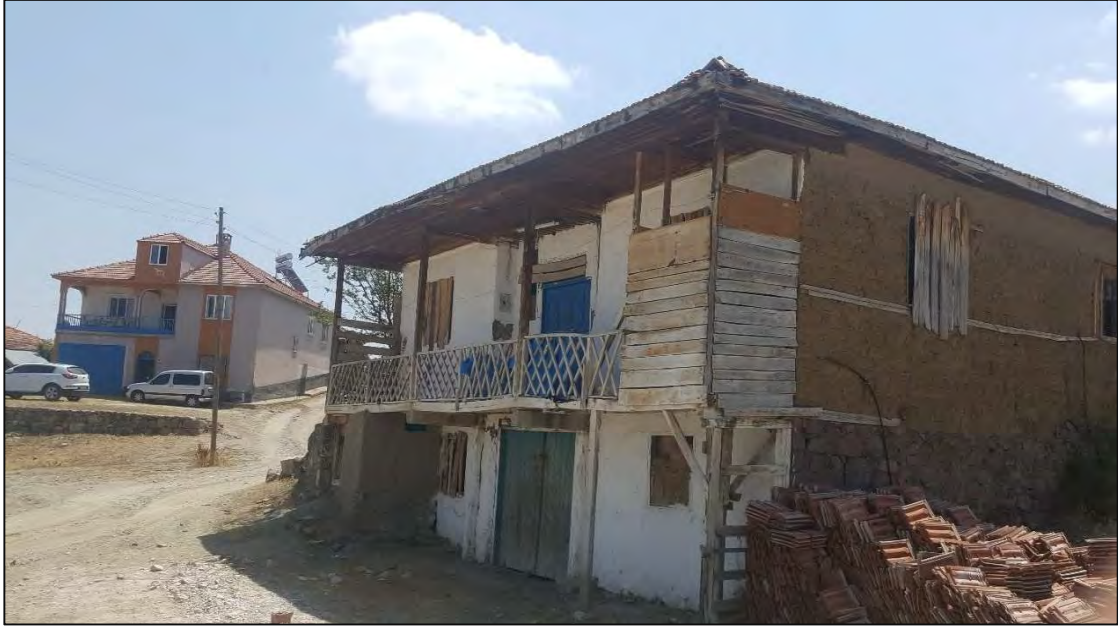
Fotoğraf 2.22. Araştırma Sahasında Yer Alan Taş ve Kerpiç (Önde) Kullanılarak ve Betonarme (Arkada) Malzeme Kullanılarak Yapılan Konutlardan Görünüm
