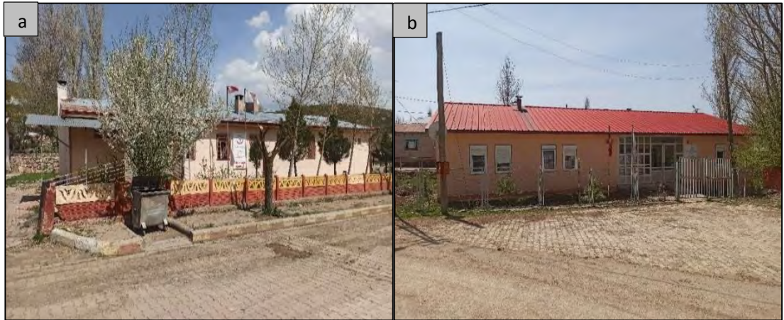
Fotoğraf 2.20. Güneykaya Aile Sağlığı Merkezi (Yenicami Mahallesi) ve Kargın Sağlık Evi’nden Görünüm
