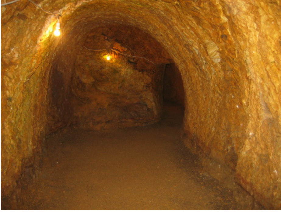
Resim 18: Yeraltı Şehrindeki Bir Galerinin Görünümü.
