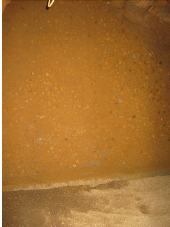
Resim 29: Yeraltı Şehrinde Restore Edilmiş Duvarlara Bir Örnek.
