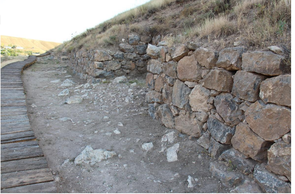
Resim 3.8. Ayanis Doğu Sur Duvarları
