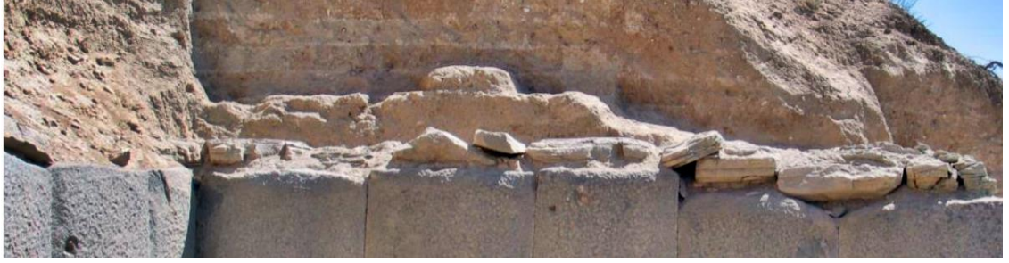
Resim 3.5. Güney Sur Löyfer Kullanımı
