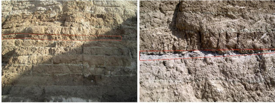
Resim 3.7. Bat Tekniğini Gösteren Fotoğraf
