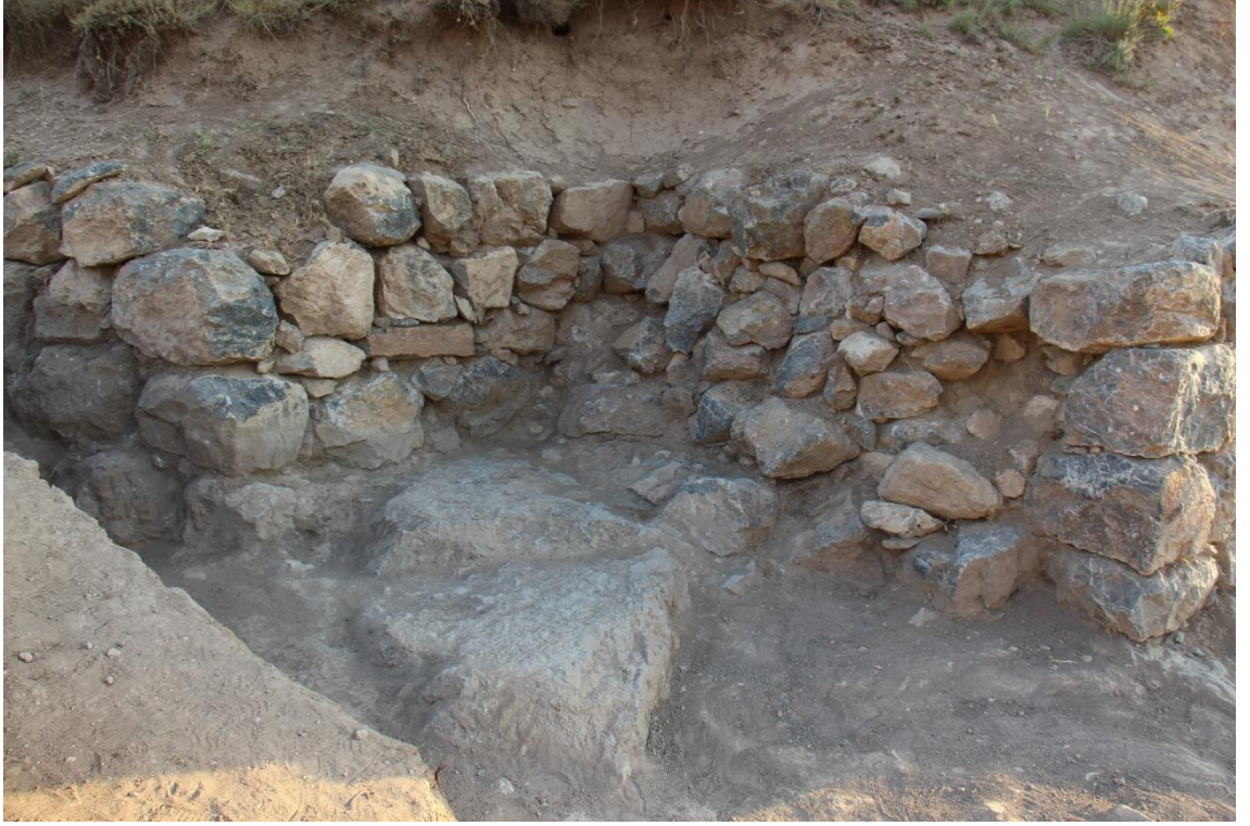
Resim 3.9. Ayanis Doğu Sur Duvarı Kurt Dişi Tekniğini Gösteren Fotoğraf
