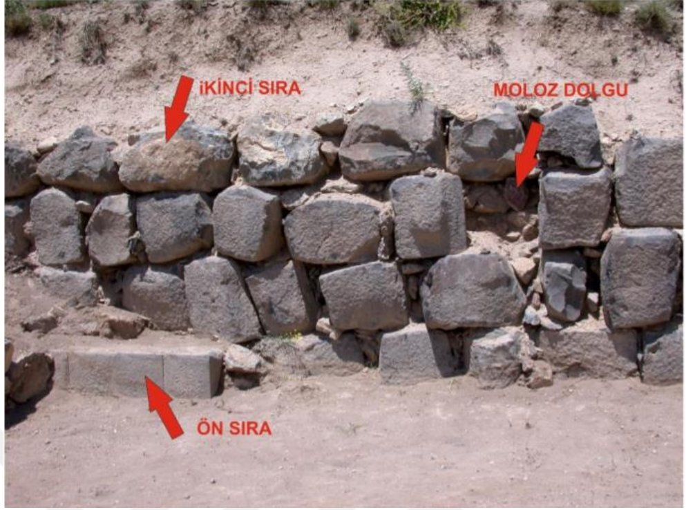
Resim 3.3. Güney Sur Alanı Sandık Duvar Tekniği
