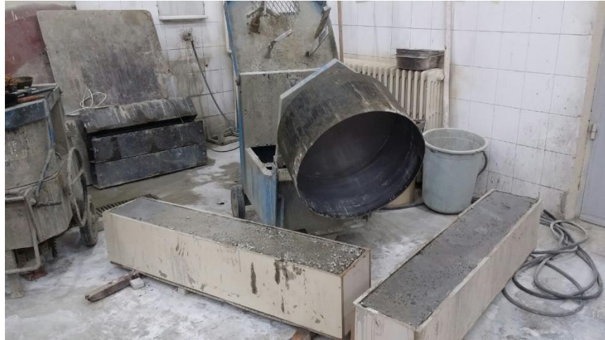
Şekil 4.30. Beton dökümü bitmiş KYB kirişleri
