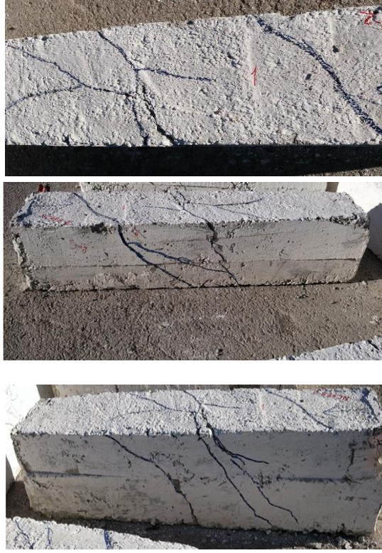
Şekil 4.25. NC4E8-2 numunesinde meydana gelen burulma çatlakları
