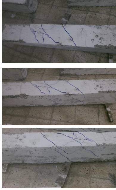
Şekil 4.51. KC4E8-1 numunesinde meydana gelen çatlaklar
