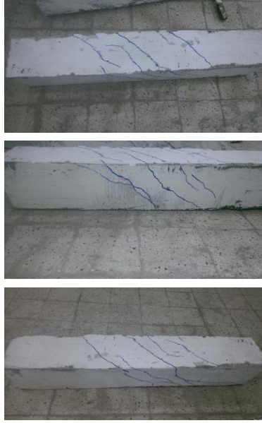
Şekil 4.49. KC2E10-1 numunesinde meydana gelen çatlaklar
