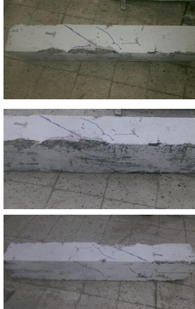
Şekil 4.52. KC4E8-2 numunesinde meydana gelen çatlaklar
