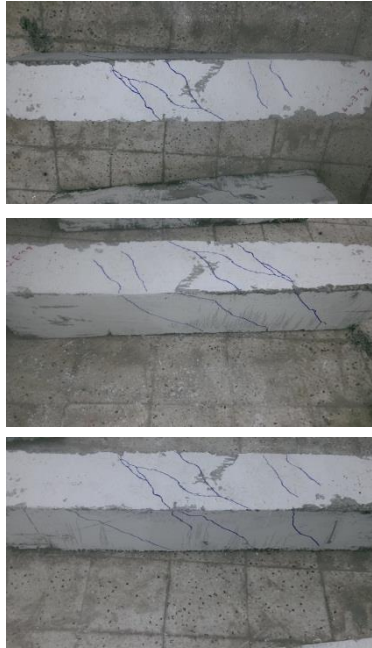
Şekil 4.50. KC2E10-2 numunesinde meydana gelen çatlaklar
