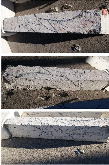
Şekil 4.26. NC4E8-3 numunesinde meydana gelen burulma çatlakları
