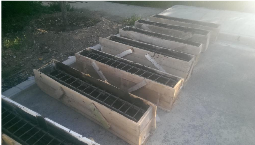
Şekil 4.1. Kalıplarına oturtulmuş kiriş numuneleri
