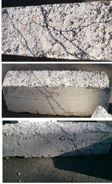
Şekil 4.23. NC2E10-3 numunesinde meydana gelen burulma çatlakları
