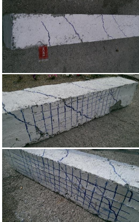
Şekil 4.24. NC4E8-1 numunesinde meydana gelen burulma çatlakları
