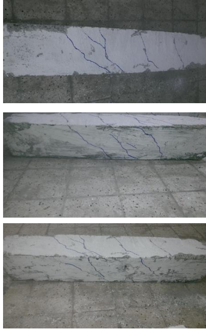
Şekil 4.47. KC2E8-1 numunesinde meydana gelen çatlaklar
