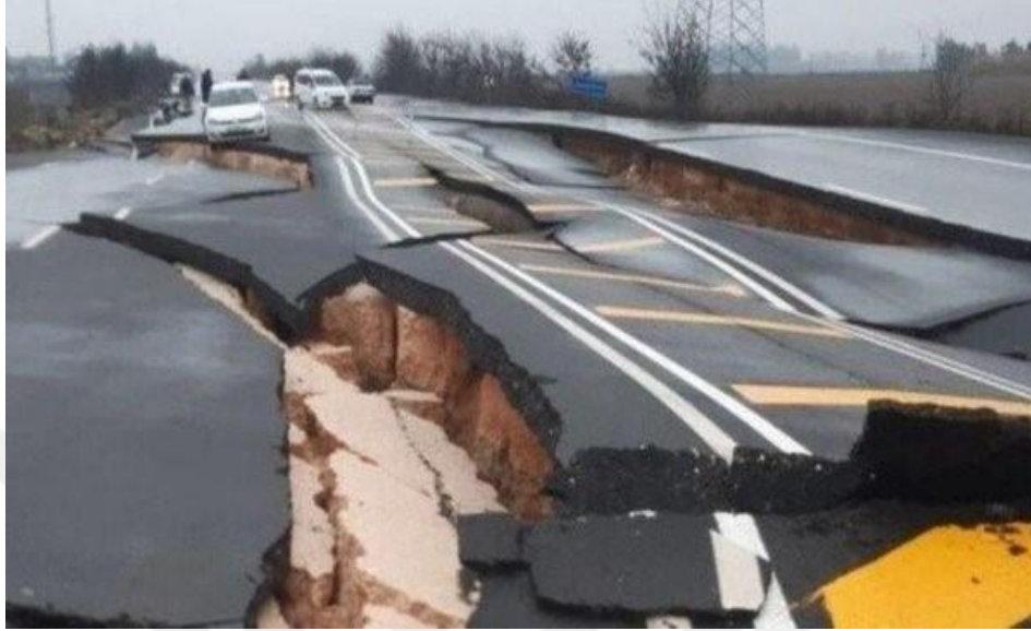
Şekil 19. 6 Şubat 2023 Kahramanmaraş (Pazarcık- Elbistan) deprem nedeniyle otoyollarda devasa yarıkların oluşmasına örnek
