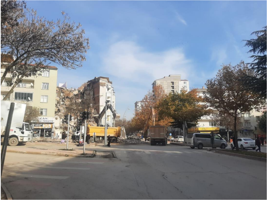
Şekil 45. 24 Ocak 2020 Elazığ depremi sonrası Yunus Emre Bulvarı yıkım ve enkaz kaldırma çalışması
