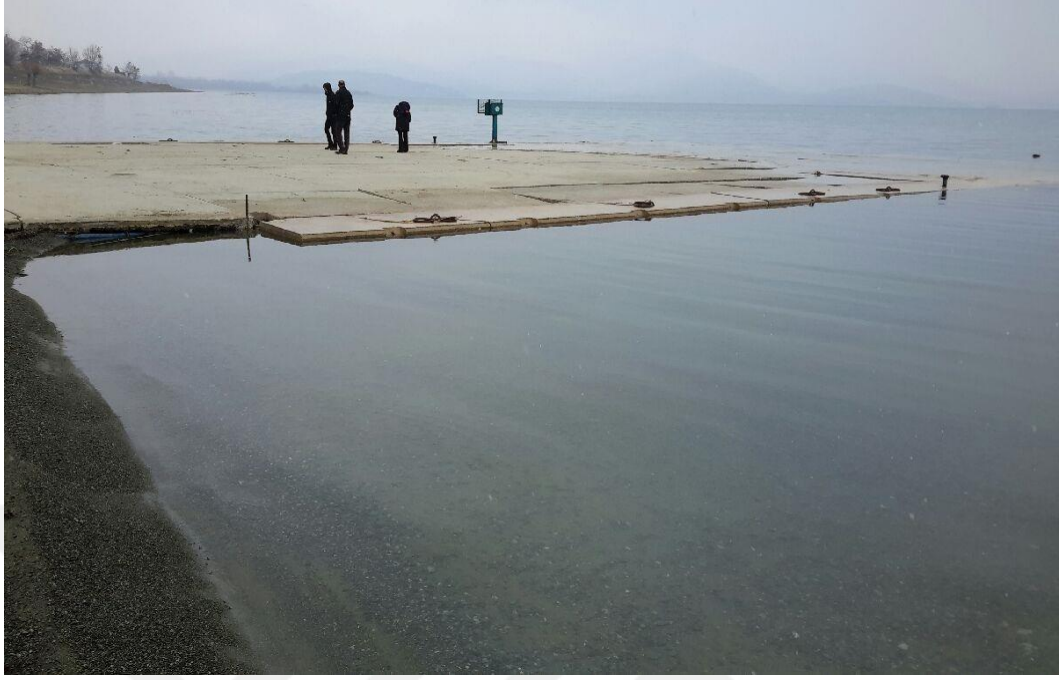
Şekil 48. 24 Ocak 2020 Elazığ depremi sonrası Sivrice iskelesinde hasar durumu (Gökçeoğlu vd 2020)
