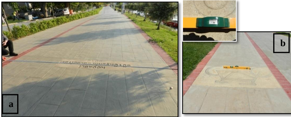
Şekil 4.8.a:Yürüyüş yolu ölçüm aşaması, b: Bisiklet yolu eğim ölçümü
