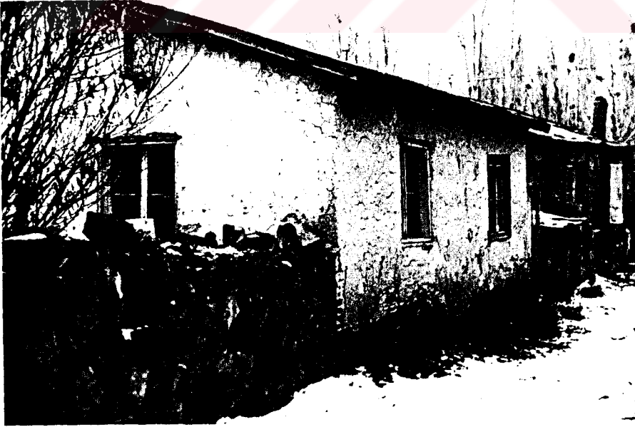
FOTOĞRAF 20. Hınıs'ta 1966 depreminde ayakta kalabilen bağdadi tipte yapılmış bir konuttan görünüm.
