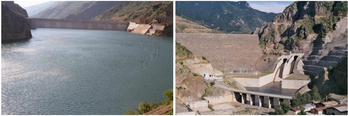
Fotoğraf 1.10. Harşit Çayı üzerinde inşa edilen Kürtün barajı (Foto: Mehmet ZAMAN).
