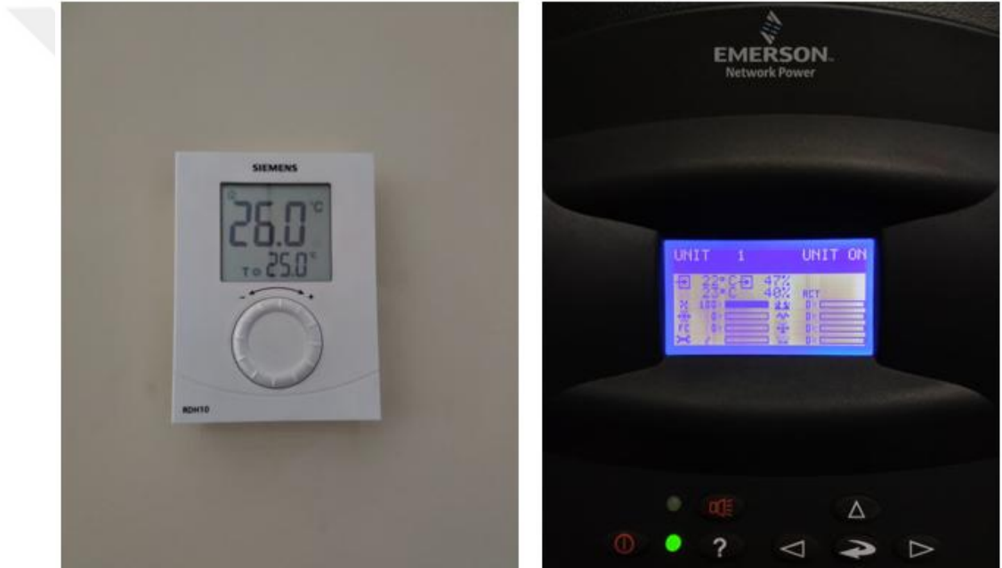
Şekil 4.6. İki farklı sensör verisinden gelen ortam sıcaklık ölçümü
