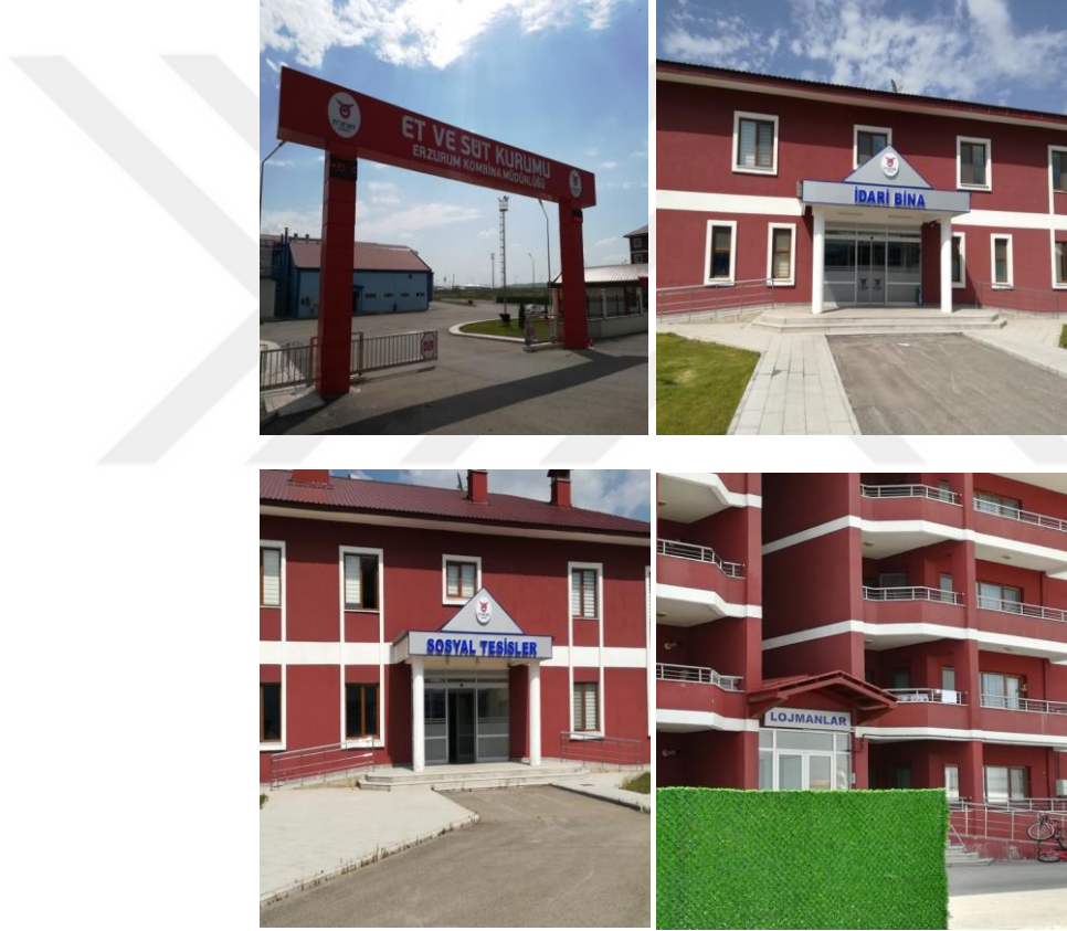
Şekil 3.5. Erzurum Kombina Tesis, idari bina, sosyal tesisler ve lojmanlar
