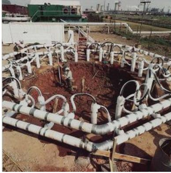
Şekil 2.7. Zemin dondurma tekniği (Briaud 2013)
