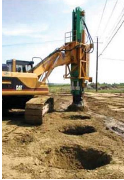
Şekil 2.2. Hızlı etkili kompaksiyon (Briaud 2013)
