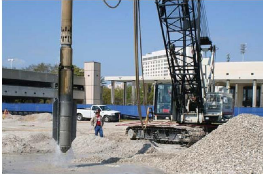
řekil 2.1. Vibrokompaksiyon rneđi (Briaud 2013)
