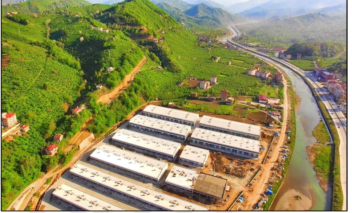
Fotoğraf 2.15. Yolgören Mahallesinde Yapım Aşamasındaki Küçük Sanayi Alanı.
