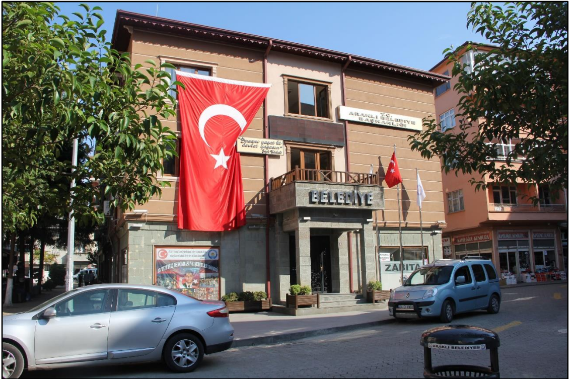
Fotoğraf 2.12. Merkez Mahallesinde Yer Alan Belediye Hizmet Binası.
