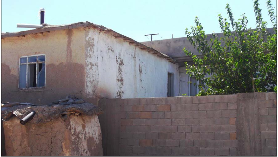
Fotoğraf 4.7. Şeyhbaba Mahallesi'nde Kerpiç ve Briketten İnşa edilmiş Eski Bir Yapıdan Görünüm.
