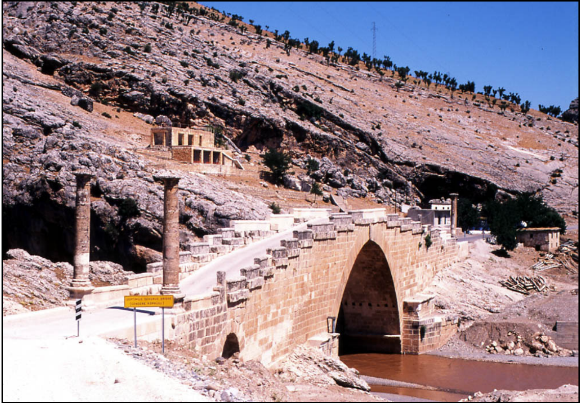
Fotoğraf 1.1. Cendere Köprüsü'nden Bir Görünüş.
