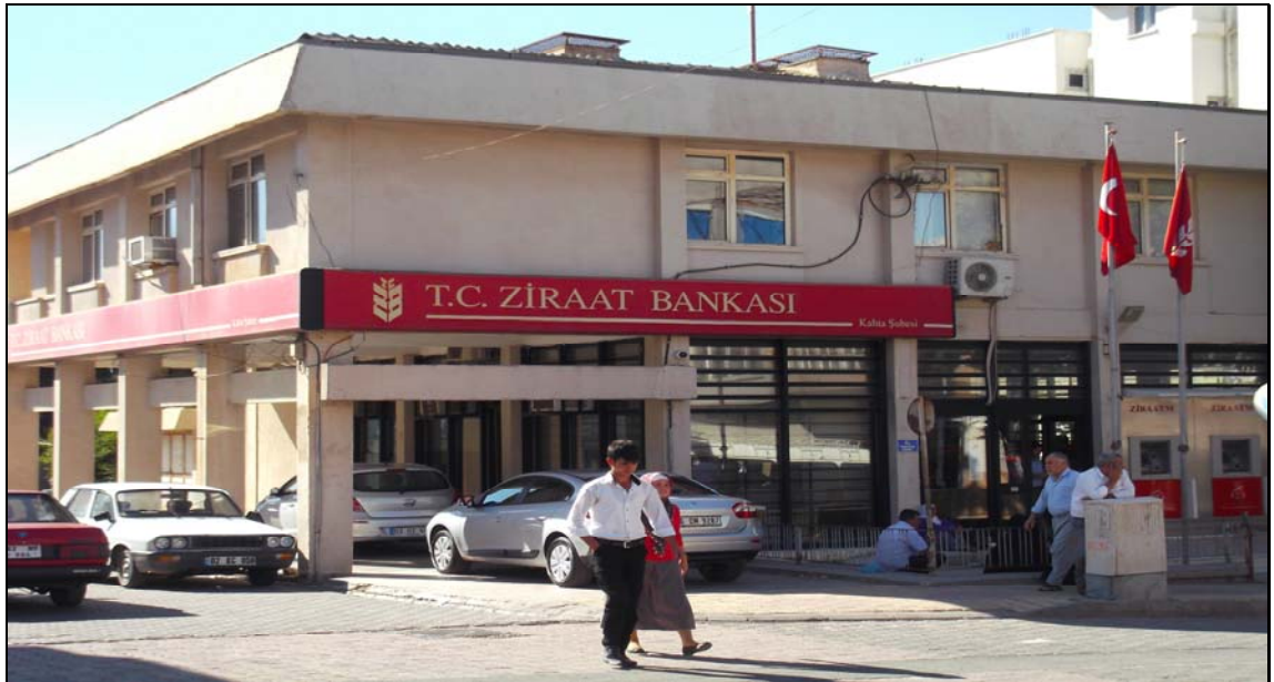
Fotoğraf 3.5. Fırat Mahallesi’ndeki Ziraat Bankası’ndan Bir Görünüm.
