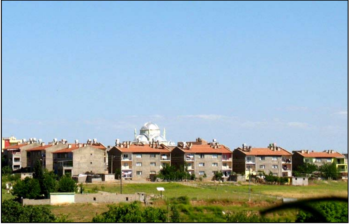
Fotoğraf 2.4. Karşıyaka Mahallesi'ndeki Afet Evlerden Bir Görünüm.
