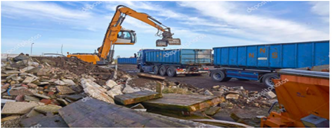
Şekil 2.3.Yapı yıkıntı atıklarının geri dönüşüm tesisine nakliyesi
