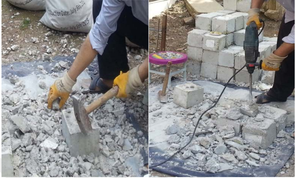
Şekil 3.2. Beton küplerinin mobil konkasörde öğütebilmek için uygun boyutlara getirilmesi çalışmaları
