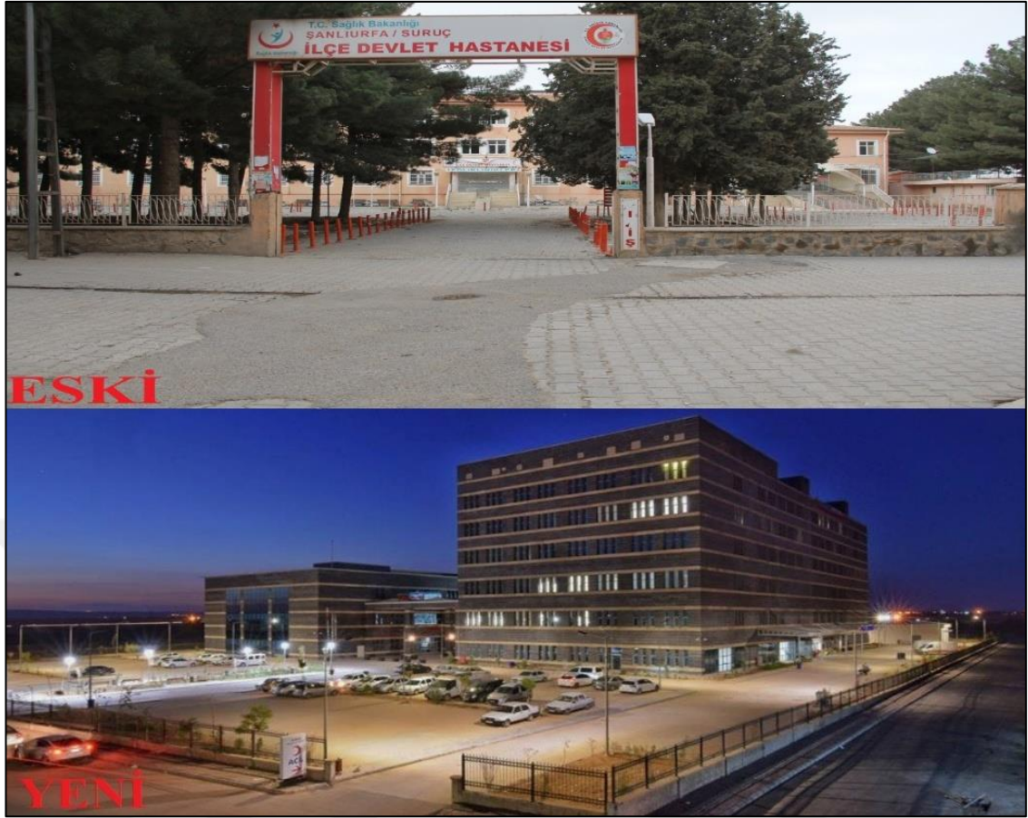
Fotoğraf 3.11. Suruç Kentinde Eski ve Yeni Yapılan Suruç Devlet Hastanesinden Görünüm.
