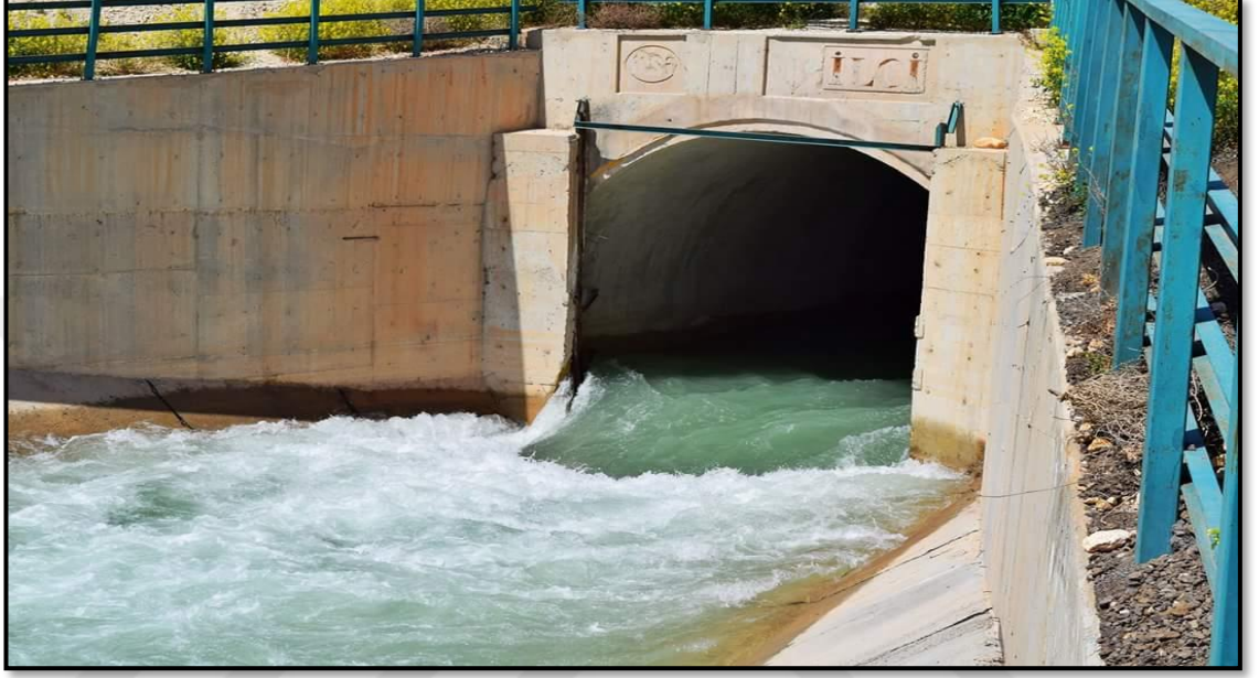
Fotoğraf 3.28. Suruç Su Tüneli'nden Görünüm.
