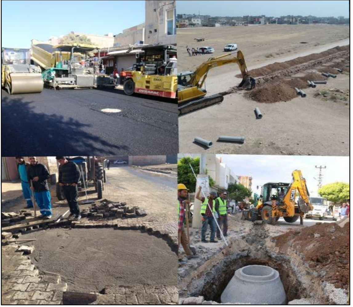
Fotoğraf 4.1. İlçe Merkezinde Altyapı Çalışma Faaliyetlerinden Görünüm.
