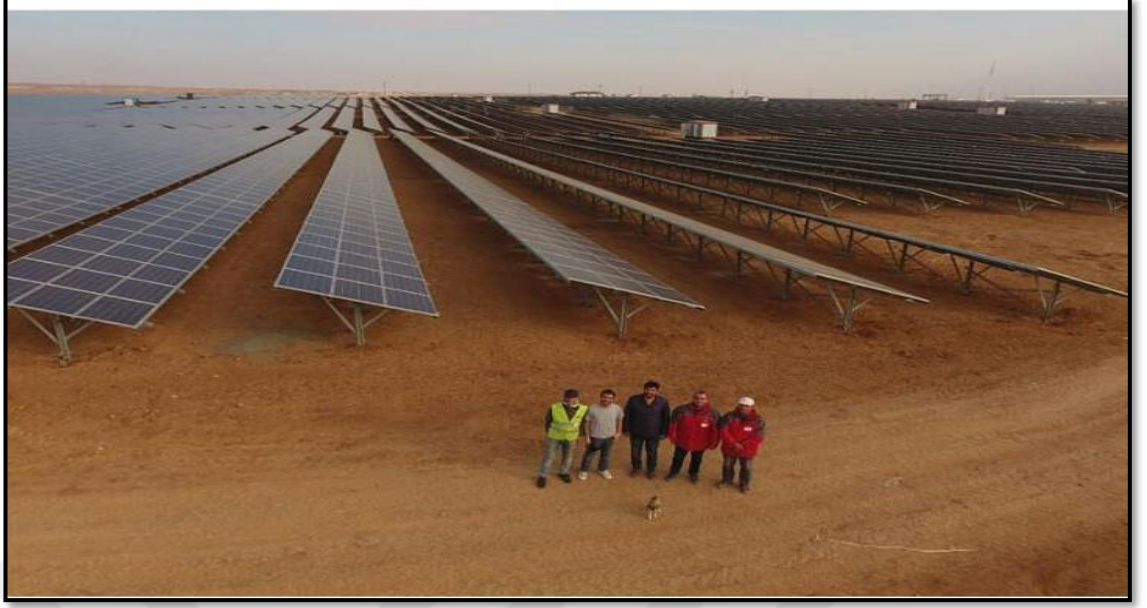
Fotoğraf 3.20. Onbirnisan Mahallesi Sınırları İçerisinde Kurulan Güneş Tarlası Santralleri’nden Görünüm.
