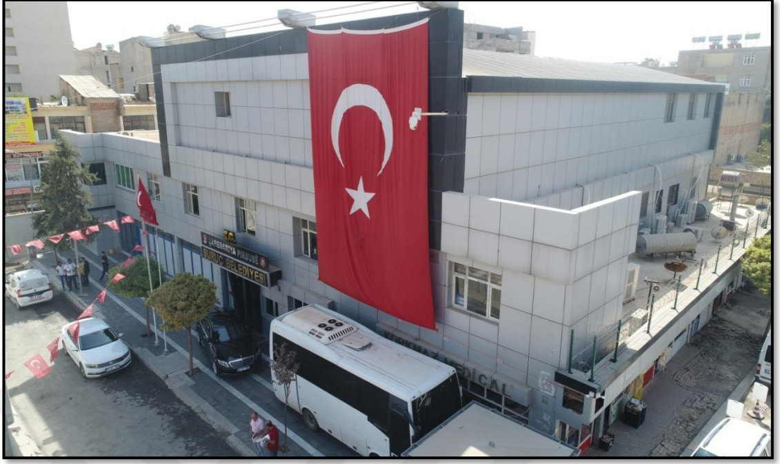
Fotoğraf 3.1. Suruç Belediyesi Hizmet Binasından Görünüm.
