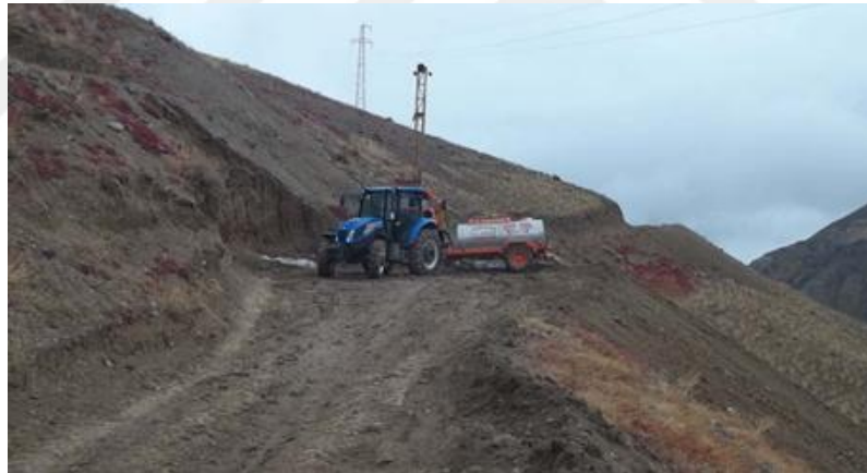
Şekil 52. Arazi sondaj çalışması
