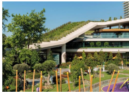
Şekil 27. Parkın yanında oluşturulan teras (XXİ Dergisi, 2014)
