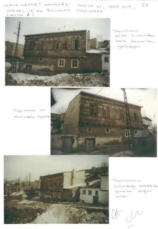
Şekil 60. Feyzullah Efendi Konağı tescil kararı (EKVKBKM 2021). Şekil 61. Konağın tescil sırasındaki durumu (EKVKBKM 2021).
