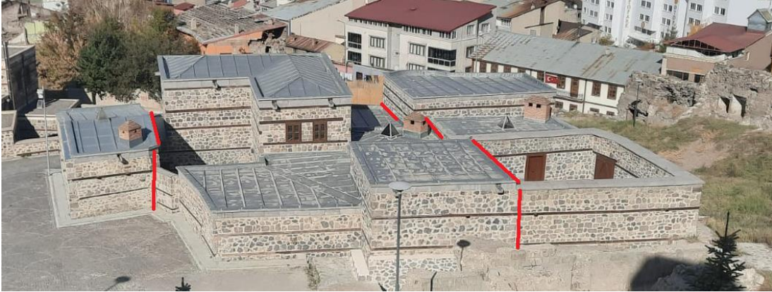
Şekil 82. Feyzullah Efendi Konağı güney görünüş.
