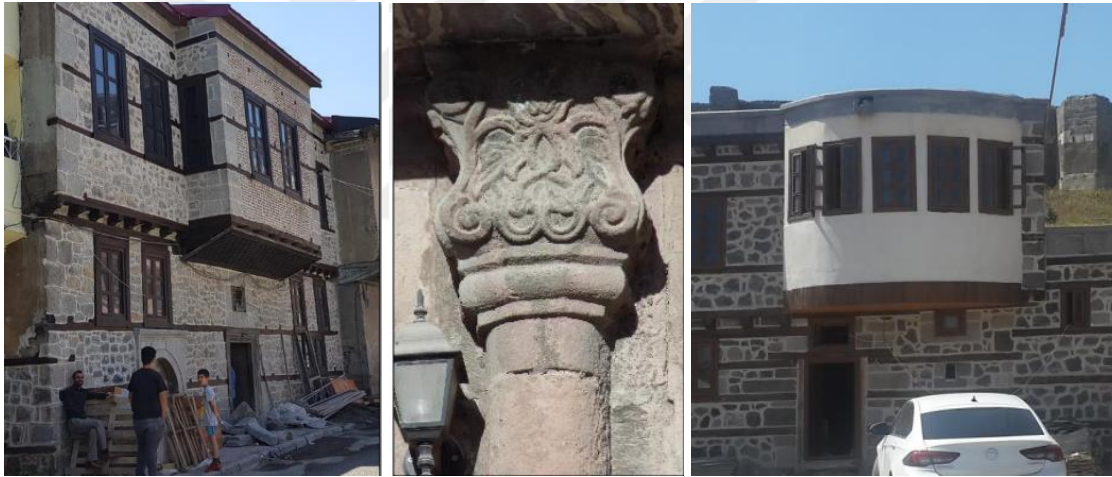
Şekil 39. Cephe süslemeleri Nemlioğlu Konağı (solda), Atatürk Evi taş sütunu (ortada), Topçu Ağa Konağı cumbası (solda) (Sağlam 2019).
