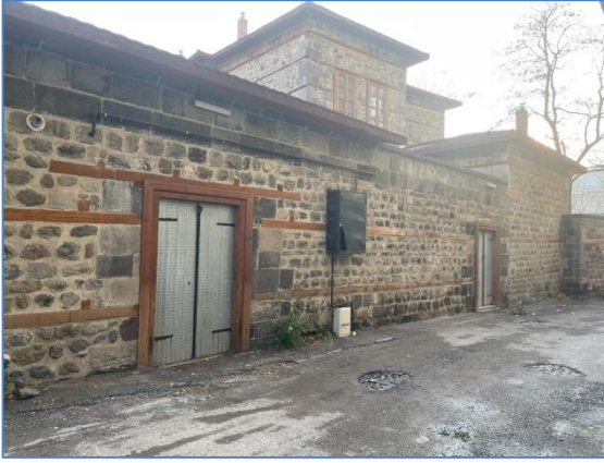
Şekil 42. Hafız Osman Konağı.
