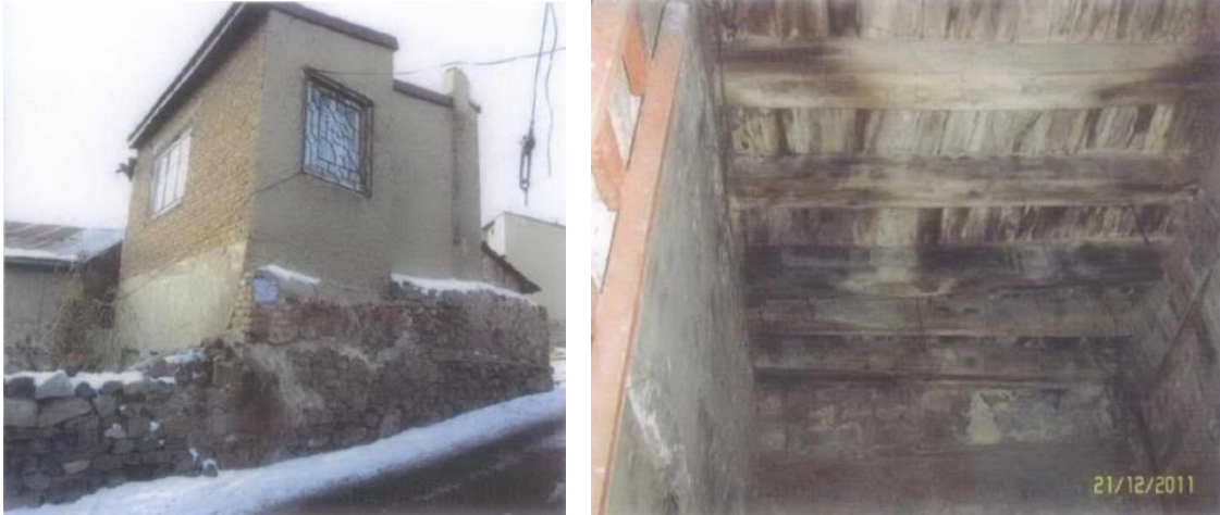
Şekil 89. Işıklılar Konağı C yapısı kuzeydoğu cephesi (solda), Işıklılar Konağı D yapısı tavanı (sağda) (EKVKBKM 2022).
