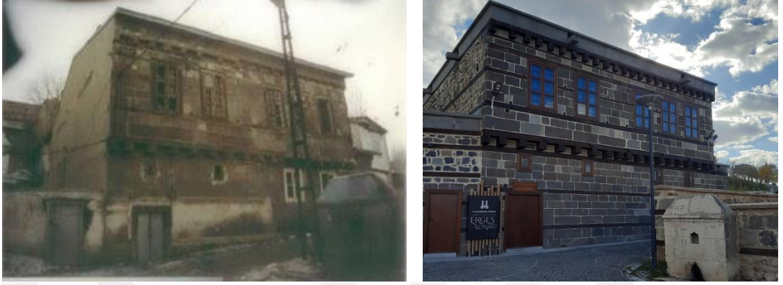
Şekil 56. Feyzullah Efendi Konağı restorasyon öncesi (solda) (EKVKBKM 2021), Feyzullah Efendi Konağı restorasyon sonrası (sağda).
