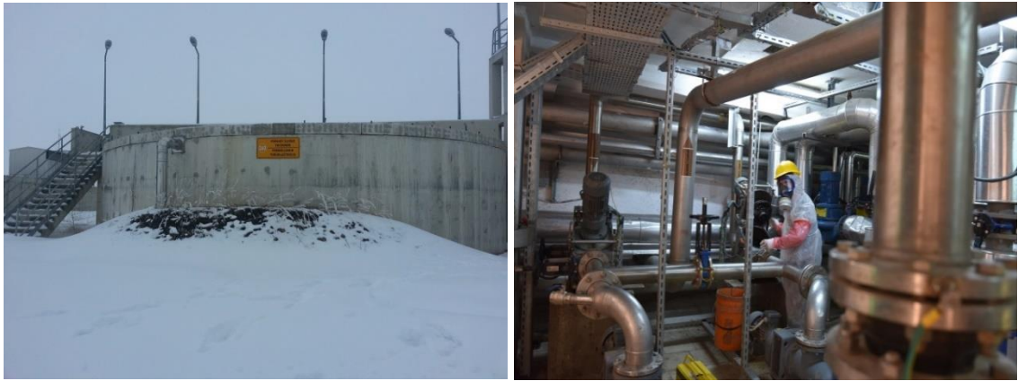
Şekil 3.21. Graviteli çamur yoğunlaştırıcı ve yoğun çamur pompa ve maseratörleri
