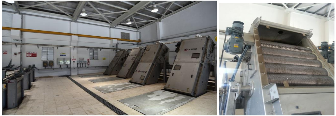
Şekil 3.9. Mekanik temizlemeli perfore tip ince ızgaraların görünümü
