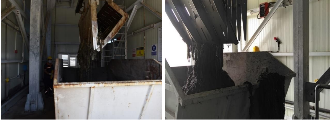
Şekil 3.6. Kepçe tipi ızgarada tutulan katı atıklar
