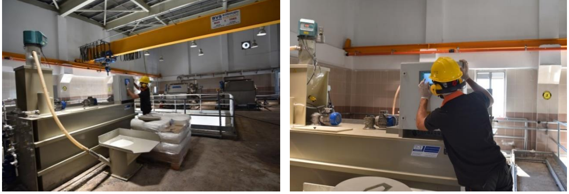
Şekil 3.34. Katyonik polielektrolit hazırlama ve dozlama üniteleri
