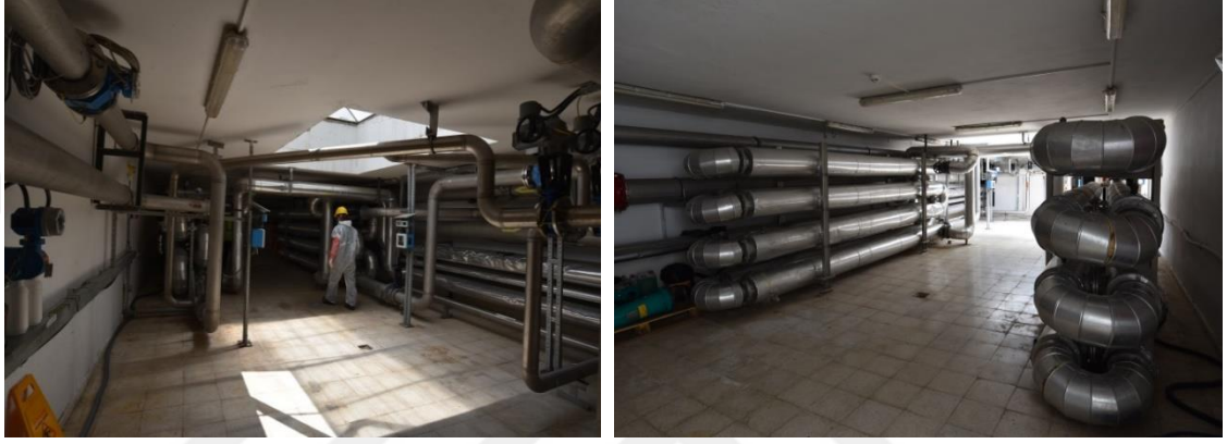
Şekil 3.27. Isı eşanjörleri (ısı değıştiriciler)
