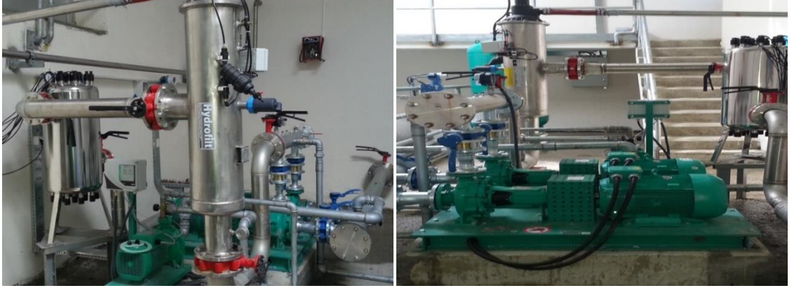
Şekil 3.37. Arıtılmış su geri kazanım sistemi
