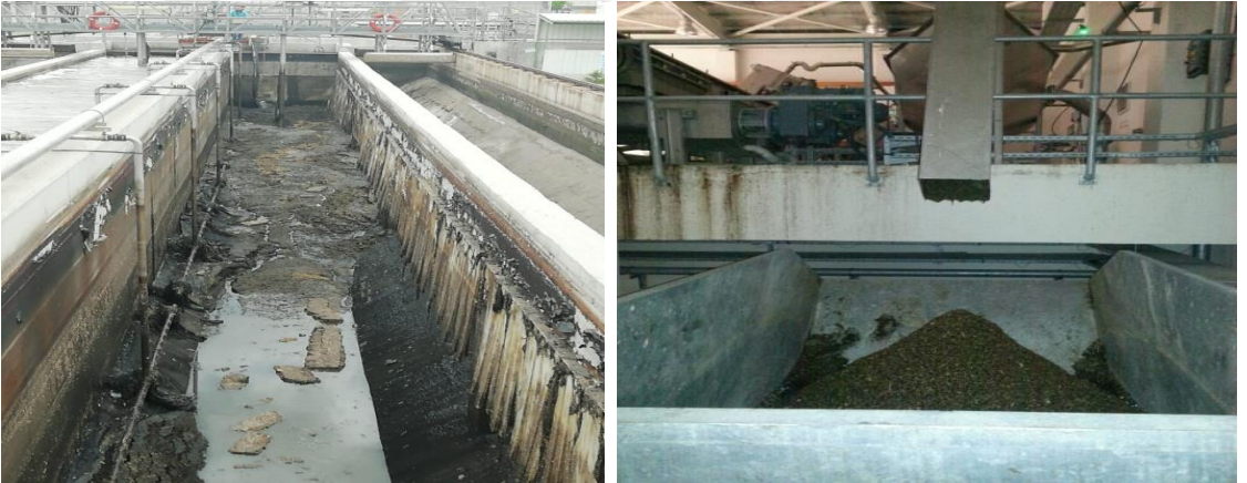
Şekil 2.2. Kum ve yağ tutucu ünite ve atıkları
