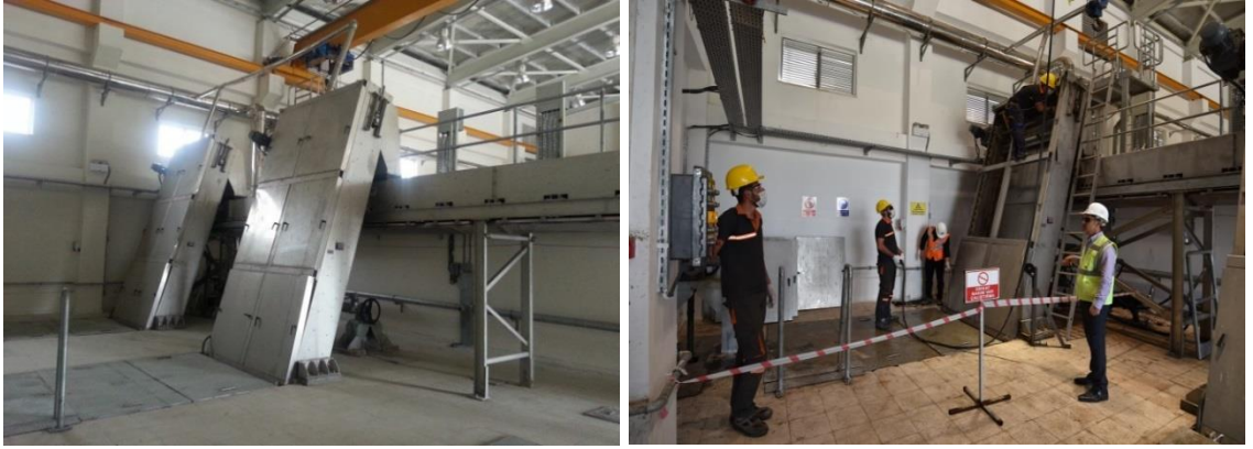
Şekil 3.8. Mekanik temizlemeli kaba ızgaralar görünümü
