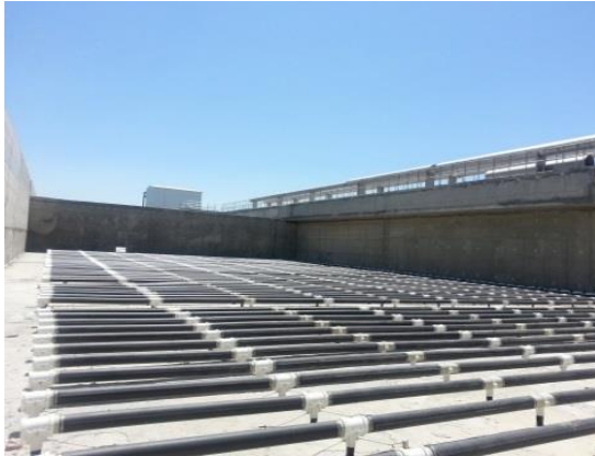
Şekil 3.15. Biyolojik havalandırma havuzu difüzörleri
