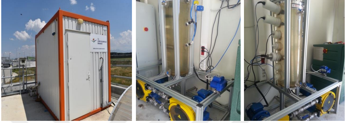
Şekil 3.38. Sürekli atıksu izleme sistemi (SAİS) görünümü
