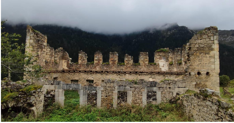
Şekil 16. Santa Harabeleri’nde Piştoflu Mahallesinde Bulunan Okul Binası (Yazarın Kişisel Arşivi 2021).
