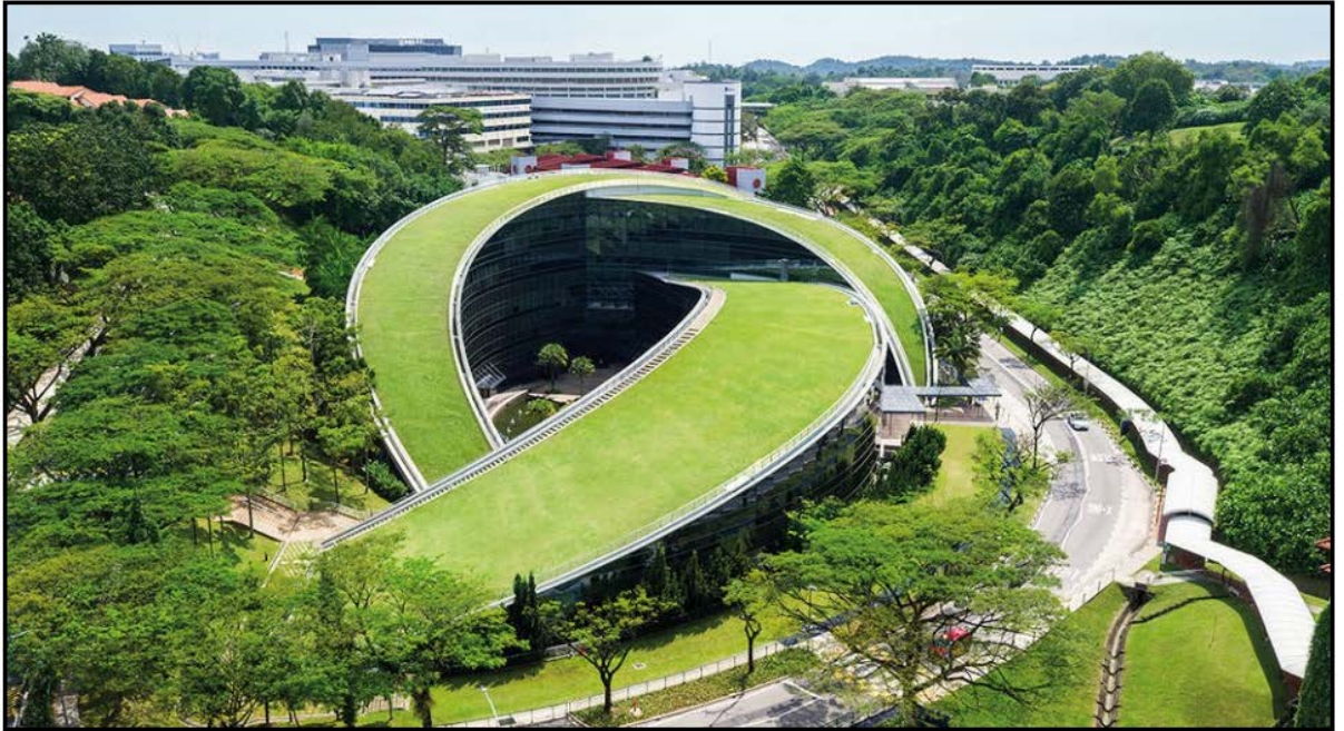
Şekil 13. Ekstensif (seyrek) bir yeşil çatı örneği(Anonim, 2018c).
