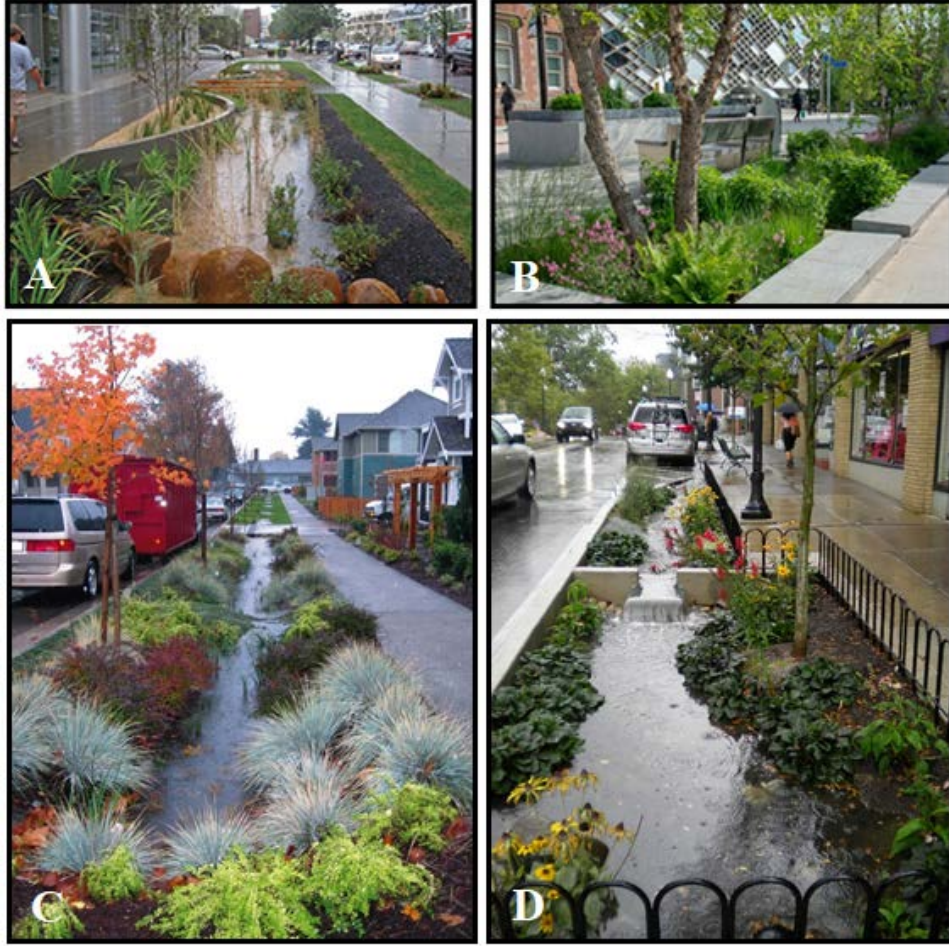
Şekil 9. Yol kenarı ve refüjlerde uygulanan yağmur bahçesi örnekleri. URL-1(Anonim, 2021b), URL-2(Dunnett, 2018), URL-3 (Anonim, 2017), URL-4 (Anonim, 2021a)
