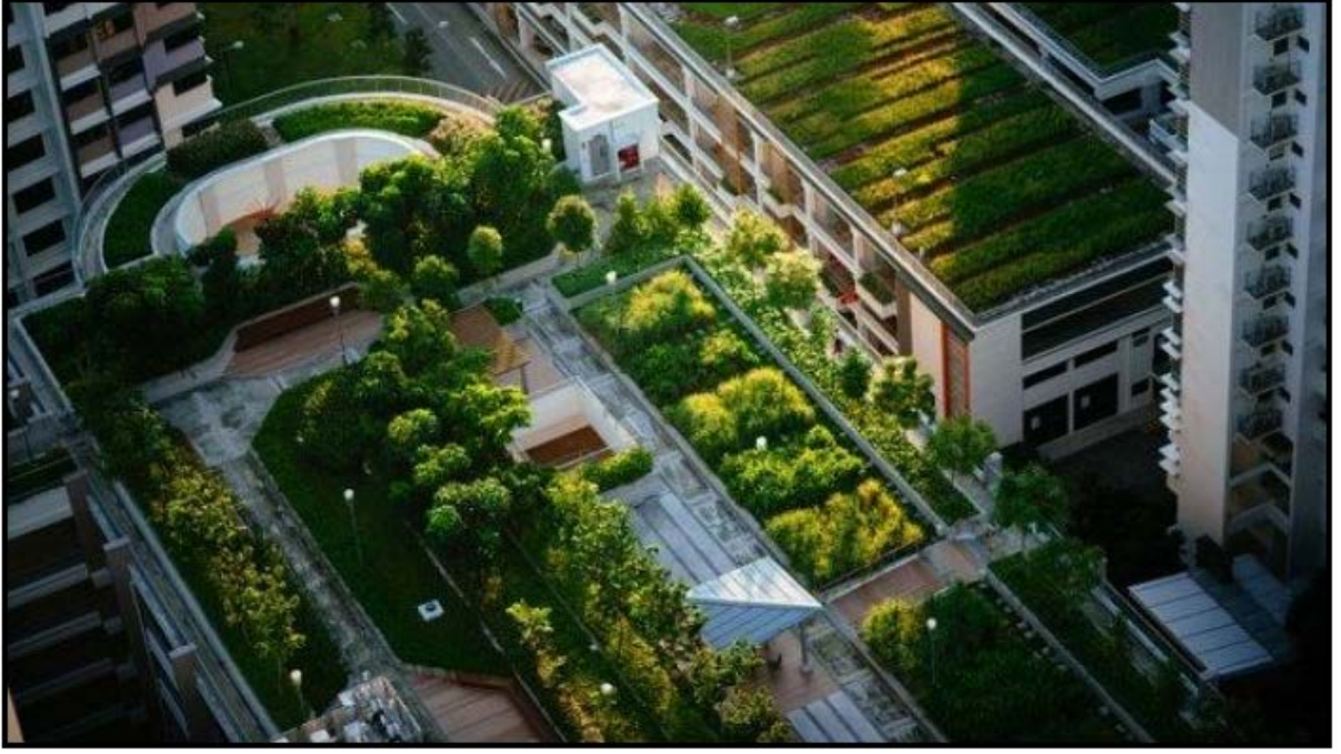
Şekil 12. İntensif (yoğun) bir yeşil çatı örneği(Anonim, 2021c).
