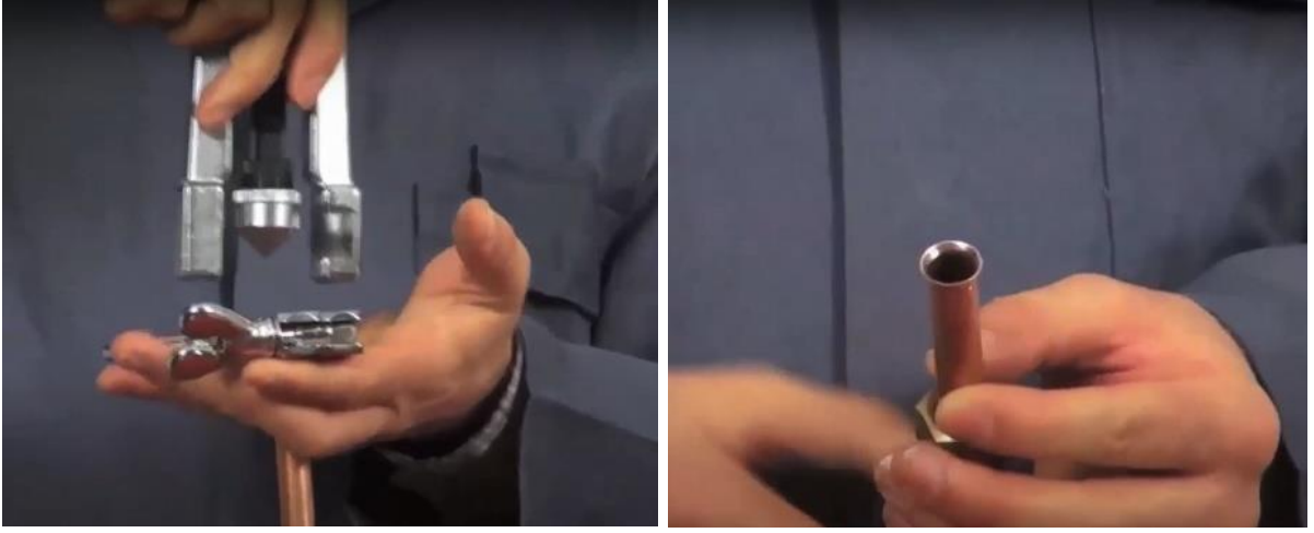
Şekil 70. Bakır boruya havşa açma işlemi.
