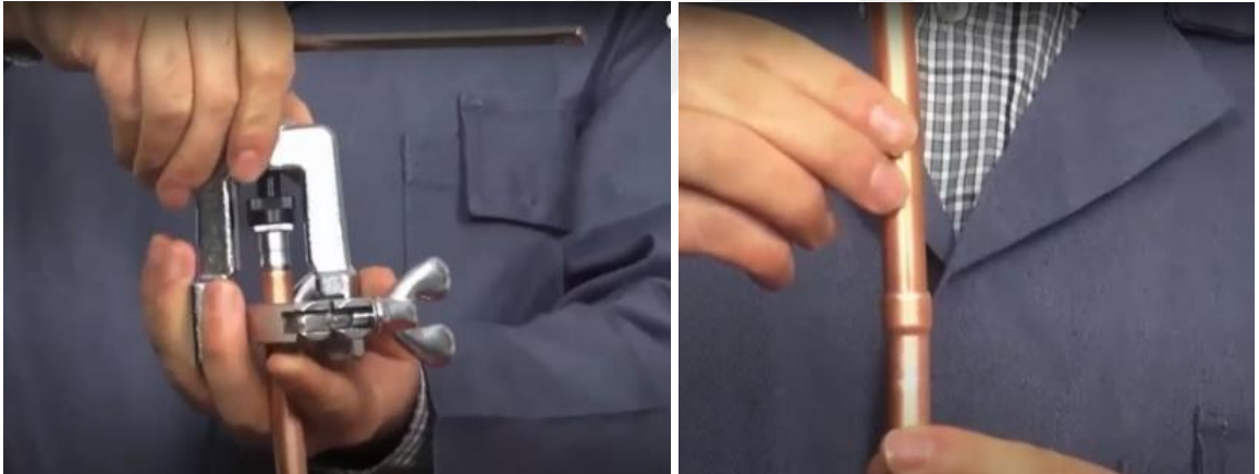
Şekil 71. Bakır borulara muf açma işlemi.
