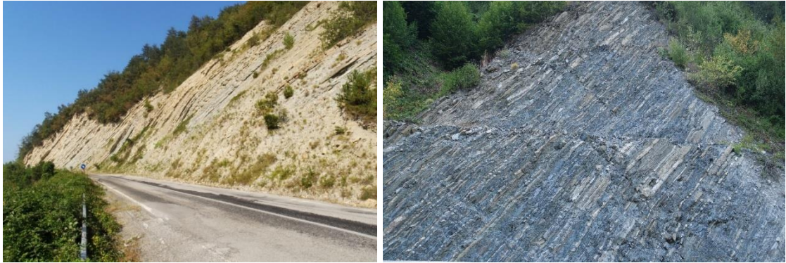
Fotoğraf 1.1. Yol Yarmalarında Ortaya Çıkan Fliş Formasyonu.
