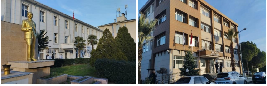
Fotoğraf 2.17. Hükümet Konağı ve Belediye Binası, Köşk ve Atatürk Caddeleri Hattı Üzerindedir.
