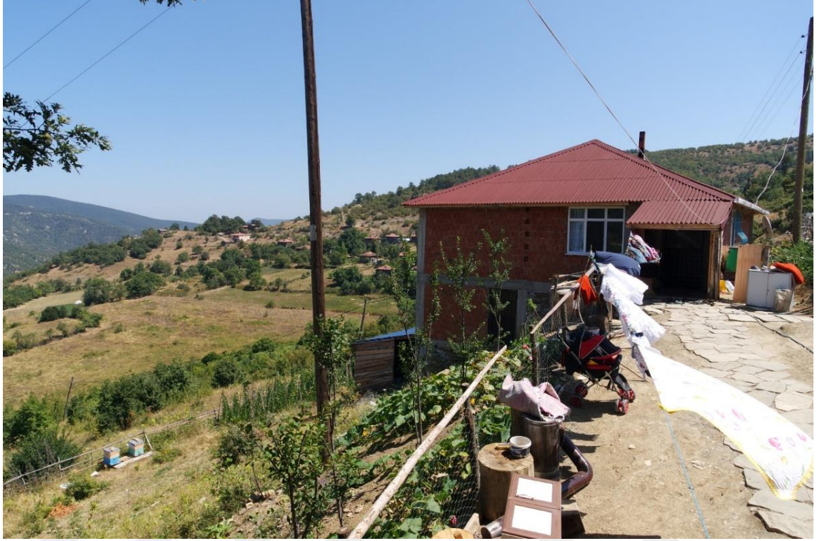
Fotoğraf 2.11. Sarnıç Köyü Şıhlı Mahallesi’nde Yeni Yapılan Betonarme Ev ve Önünde Yer Döşemesi Olarak Kullanılan Kayrak Taşları.
