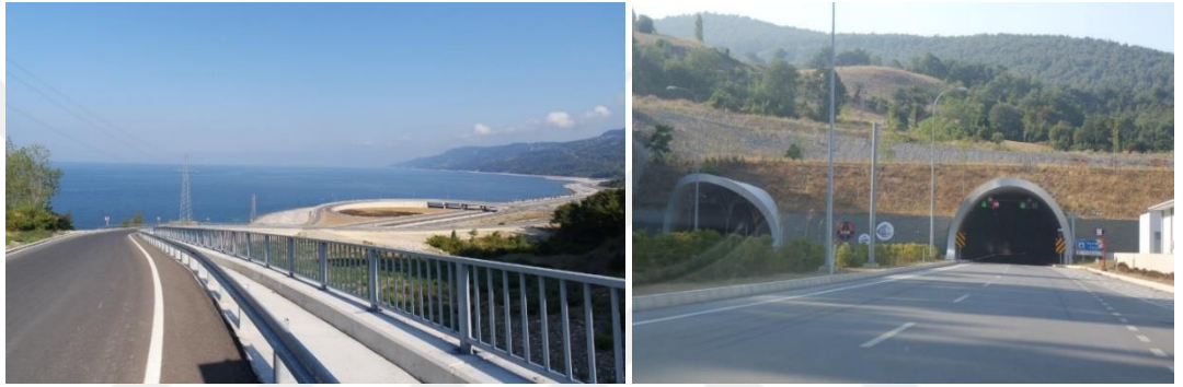
Fotoğraf 3.20. Yeni İnşa Edilen Samsun-Sinop Karayolundan Bir Görünüm.
