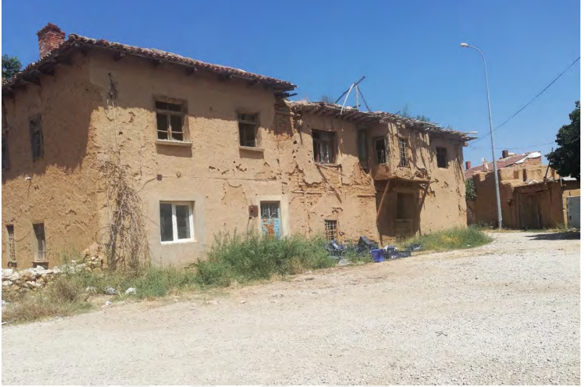
Fotoğraf 2.18. Başmakçı İlçe Merkezinde Bulunan İki Katlı Toprak Bir Ev.
