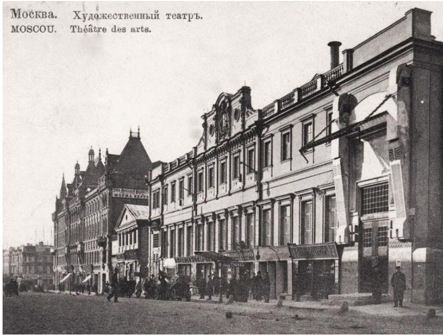
Moskova Sanat Tiyatrosu Binası
