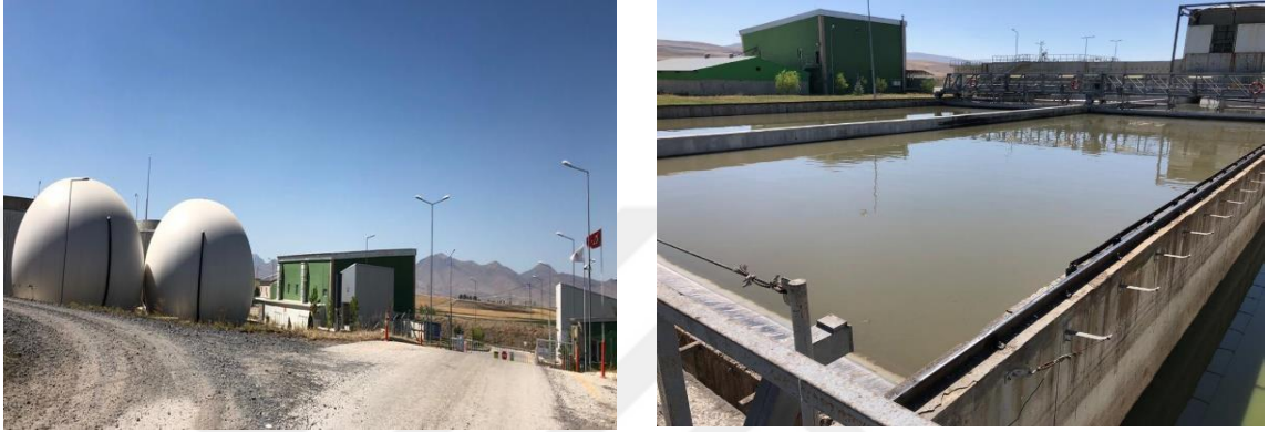
Şekil 3.2. Erzurum Biyolojik atık su arıtma tesisi
