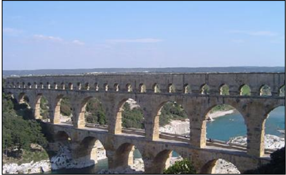
Şekil 1.3. Romalılar tarafından yapılan su kemeri Pont du Gard (Fransa)
