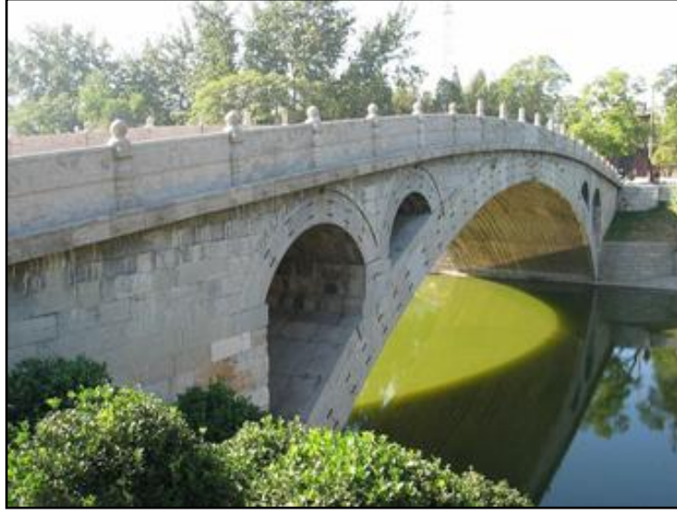
Şekil 1.4. Anji Köprüsü (Çin)
