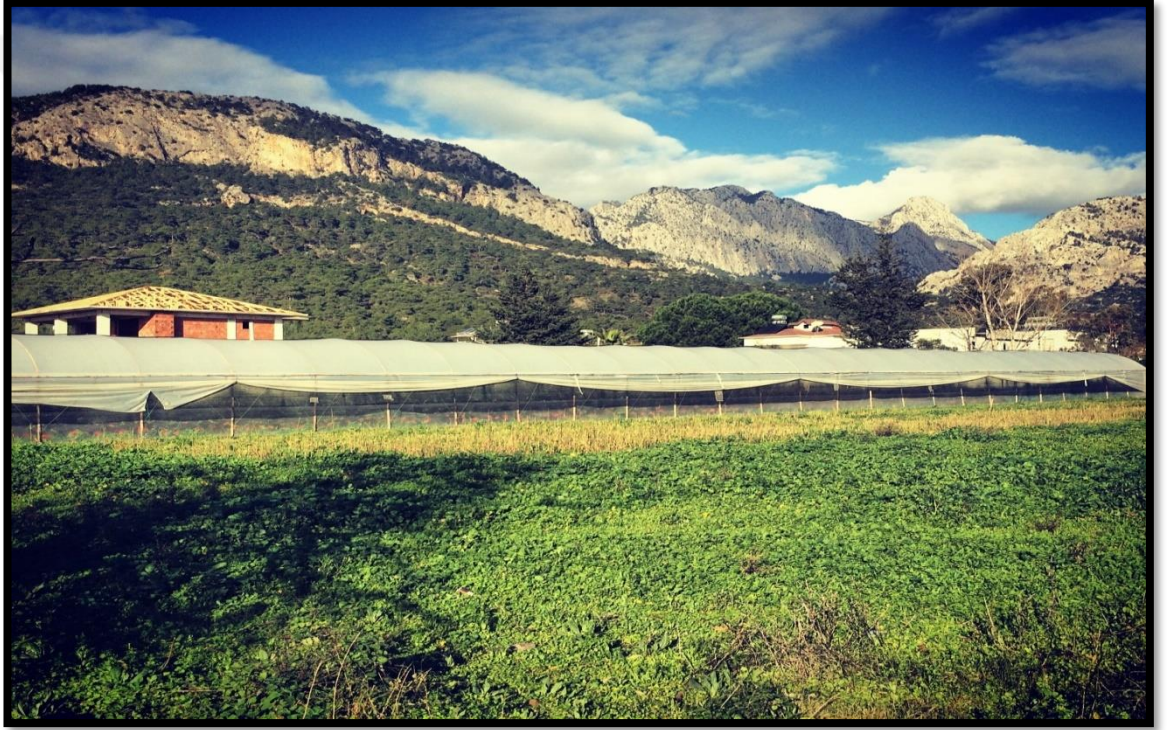
Fotoğraf 1.7. Domates serası ve hemen yanında tarım arazisine yapılan inşaatın bir görünüm.
