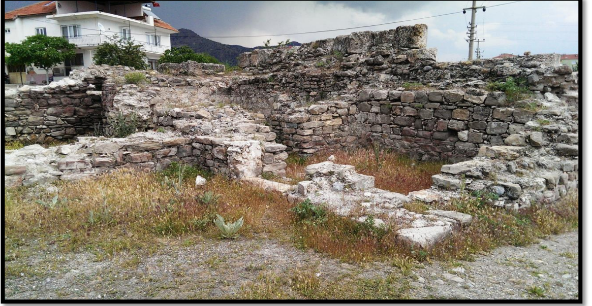
Fotoğraf 3.16. Çardak Han'ın Yıkık Duvarlarından Bir Görünüm.
