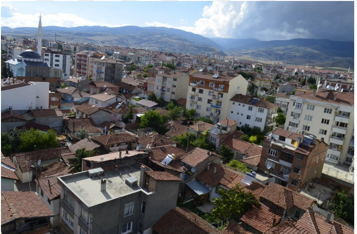
Fotoğraf 4.8. Mahsen Mahallesi'nde Gecekonduyu Andıran Yapılar.
