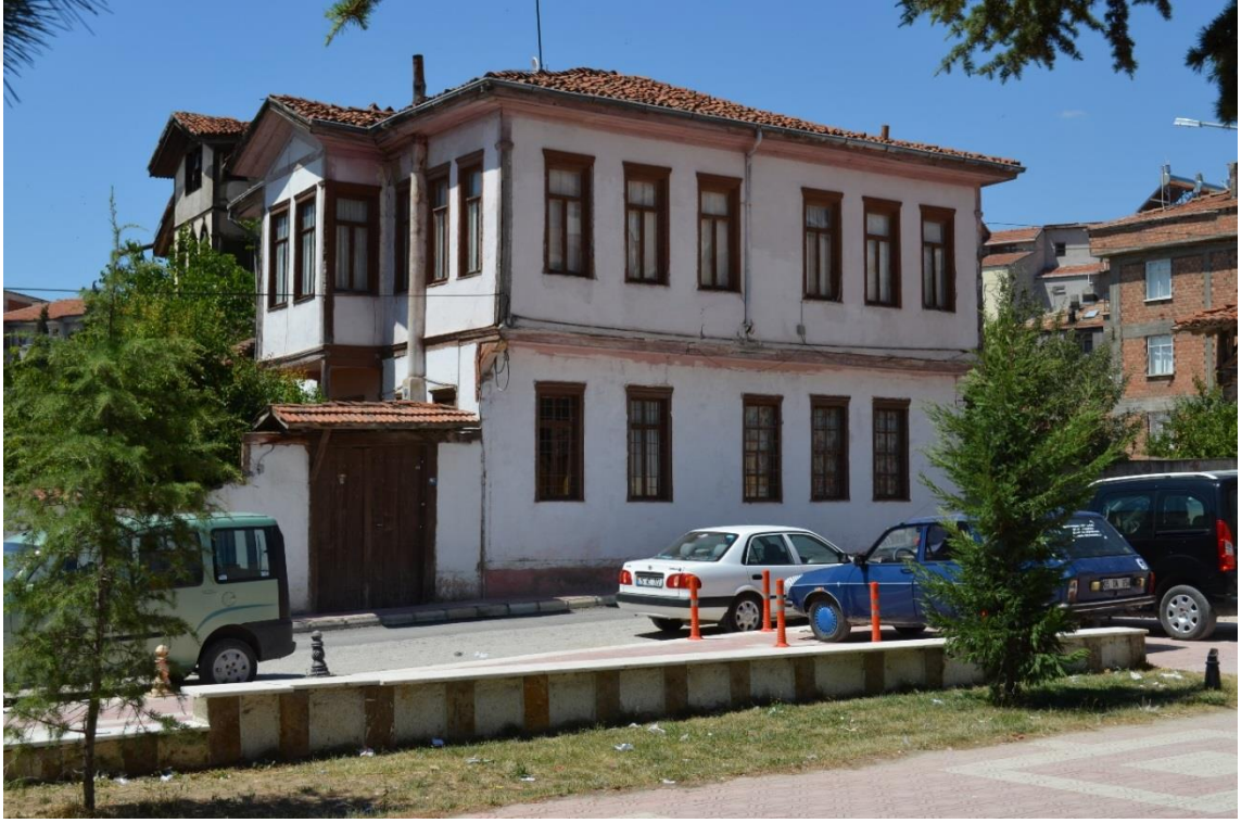
Fotoğraf 4.3. Restorasyon Çalışmalarını Bekleyen Geleneksel Bir Konut.
