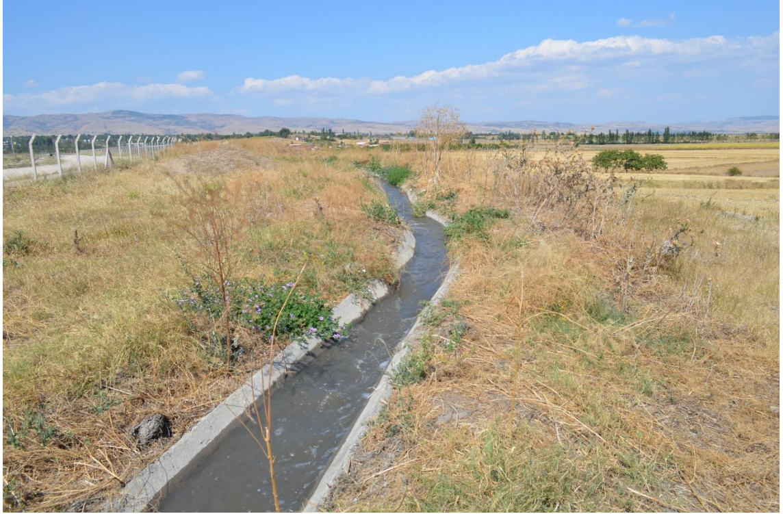
Fotoğraf 4.6. Merzifon Organize Sanayi Bölgesi'nin Kenarından Geçen Atık Su Hattı
