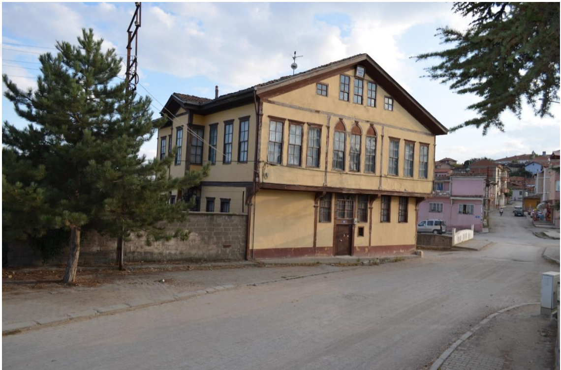
Fotoğraf 3.8. Nusratiye Mahallesi'nde restorasyon çalışmalarını bekleyen Merzifon Evi
