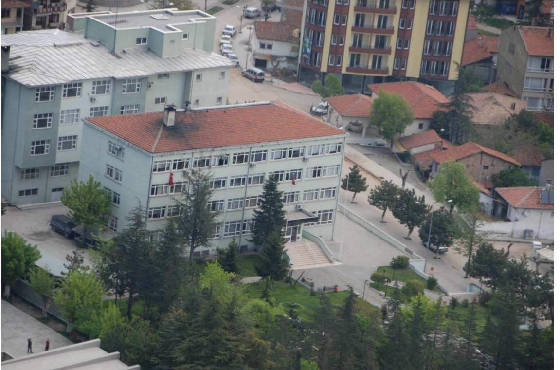
Fotoğraf 2.15. Sofular Mahallesi'nde Yer Alan Kaymakamlık Binası.
