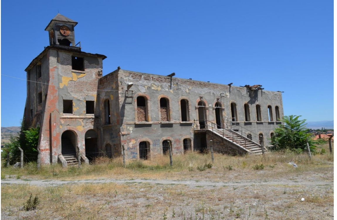
Fotoğraf 2.5. Kuzey Koleji'nin Bugünkü Durumu.
