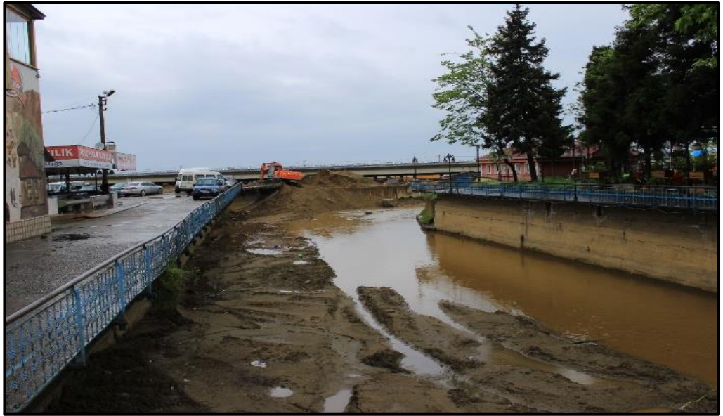
Fotoğraf 5.1. Dolana Deresinde Akarsuyun Taşıdığı Malzemenin Kaldırma Çalışmaları.
