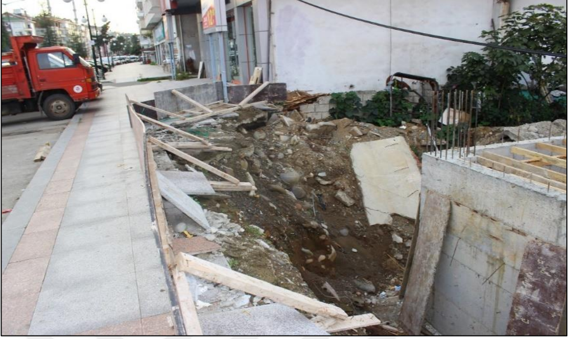
Fotoğraf 3.22. Yeni Mahallesi Atatürk Caddesi Üzerinde Yer Alan Bir İnşaatın Temel Görüntüsü.
