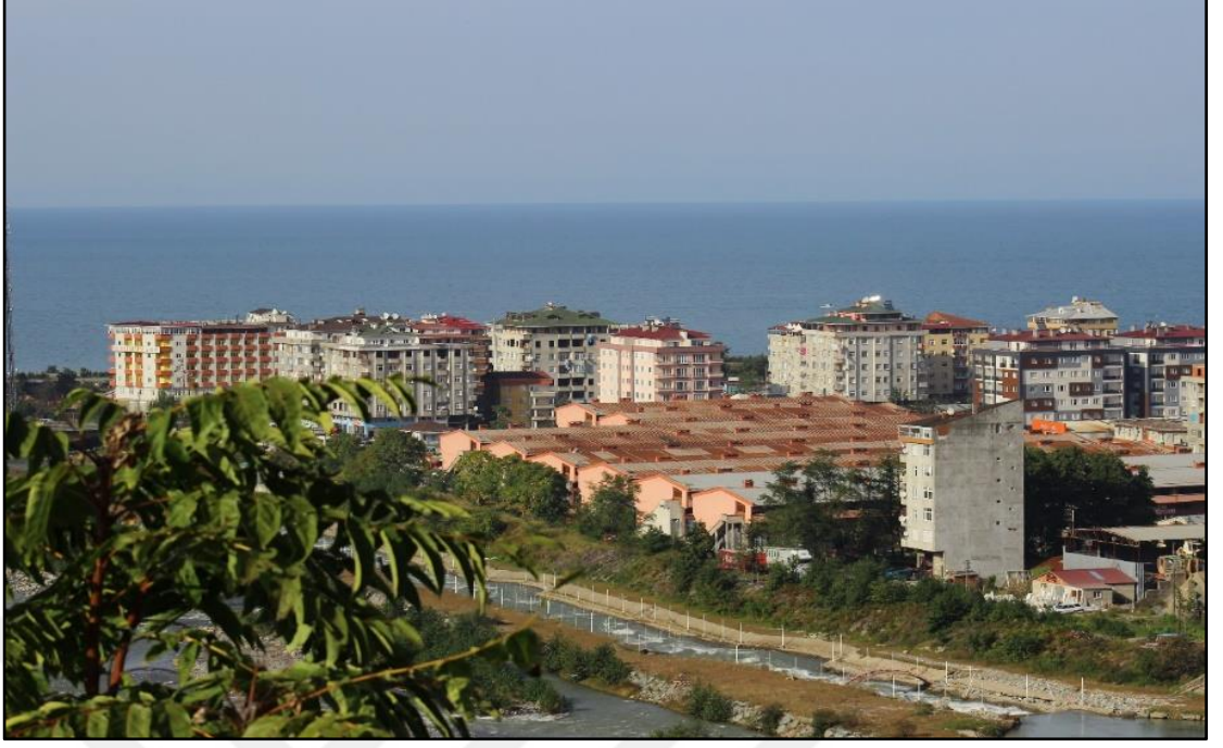
Fotoğraf 3.21. Elmalık Mahallesi'nden Fırtına ve Deniz Mahallerindeki Çok Katlı Yapıların Görünümü.
