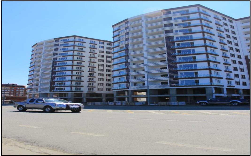
Fotoğraf 2.7. Deniz Mahallesi'nde İnşaa Edilmiş Olan Çok Katlı Yapılar.
