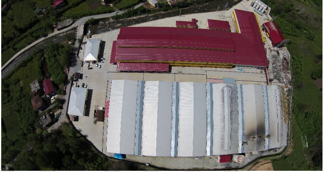
Fotoğraf 2.6. Işık Mahallesi'nde Bulunan ve Betonarme Şekilde İnşaa Edilen ÇAYKUR Fabrikası.
