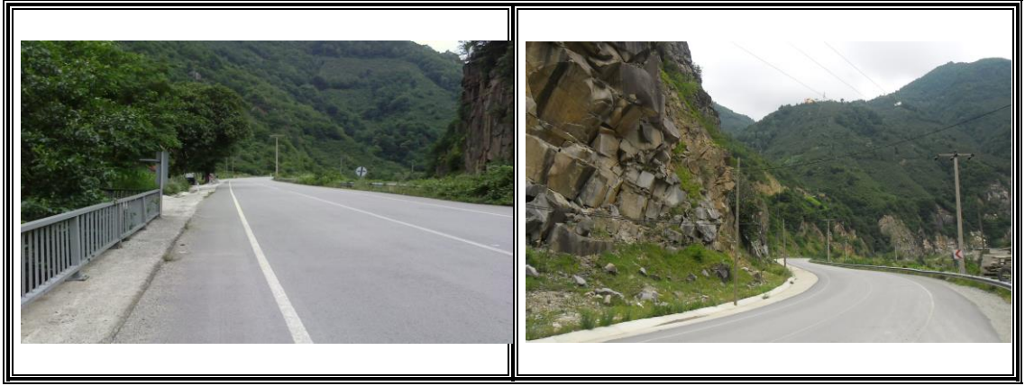
Şekil 4.25. Doğankent- Kürtün karayolunda genel görünüm
