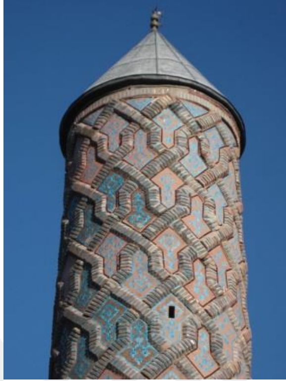
Fotoğraf 10. Erzurum Yakutiye Medresesi, (Minarenin dış süslemesinde kullanılan, sırlı tuğla tekniği detayı)
