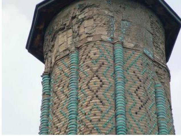
Fotoğraf 11. İnce Minareli Medrese Konya, (minarelerin dış süslemesinde kullanılan, sırlı tuğla mozaik tekniği detayı)
