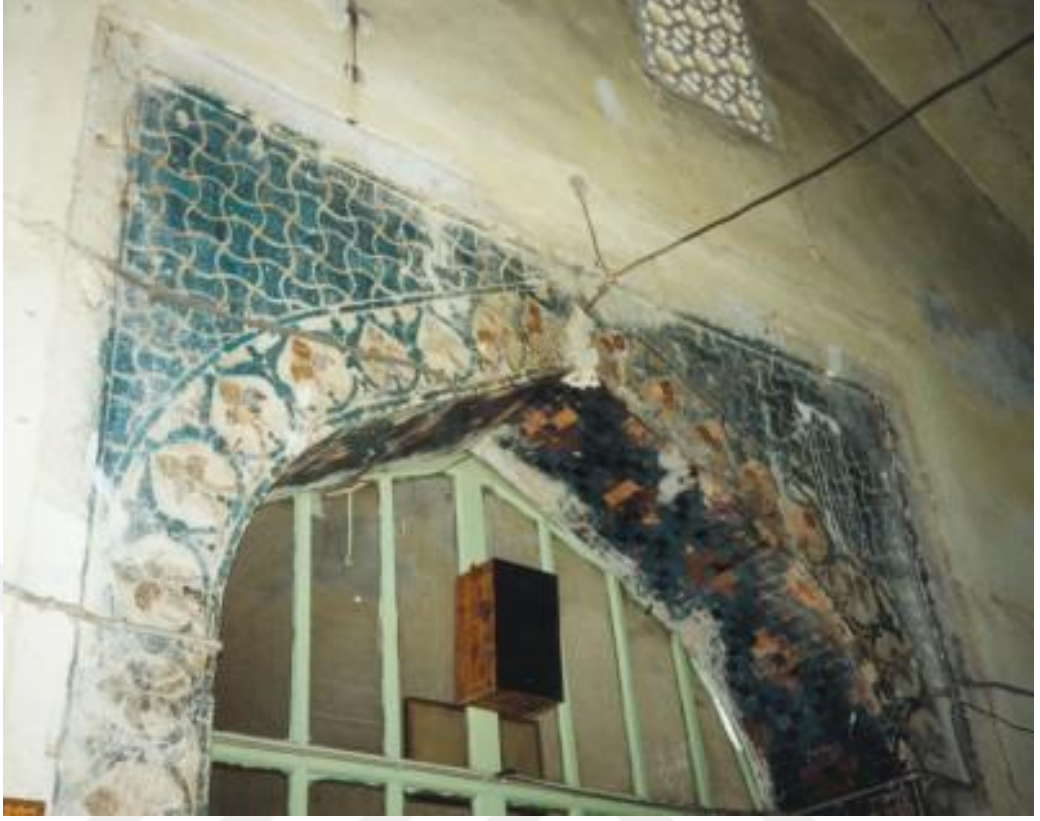
Fotoğraf 14. Çay Taş Medresesi Afyon, (Kazıma mozaik tekniği ile yapılmış, kemer detayı)
