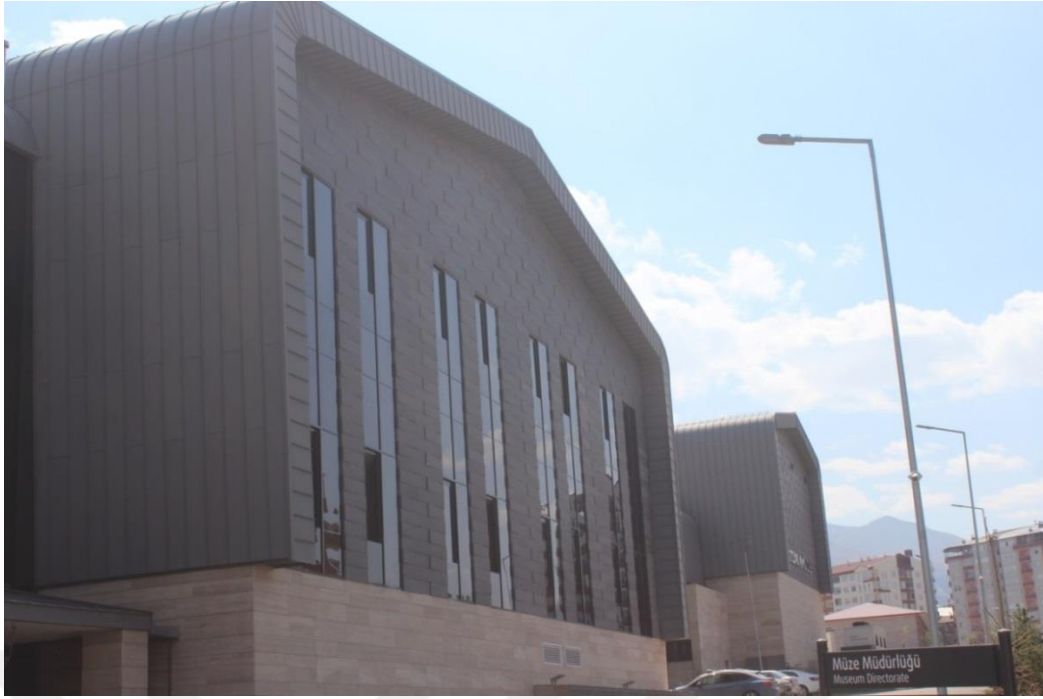
Şekil 24. Titanyum cephe kaplaması (Yazarın kişisel arşivi 2021).
