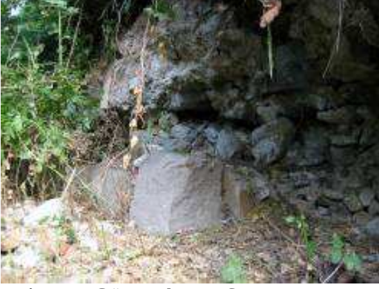
Resim 51: Güney Agora Sur Duvarı Duvar Örgüsü
