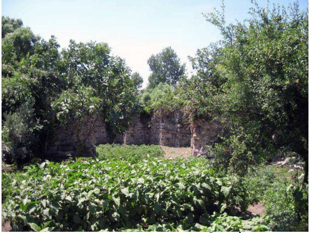
Resim 184: Birinci Altugen Kule Temizlik Öncesi İç Mekân
