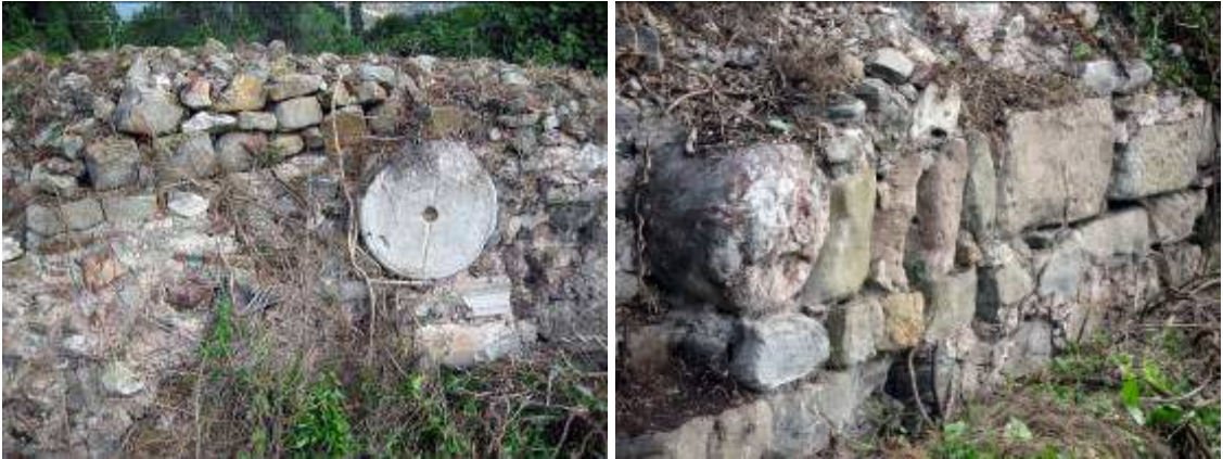
Resim 15-16: Güney Surları-Devşirme Malzeme
