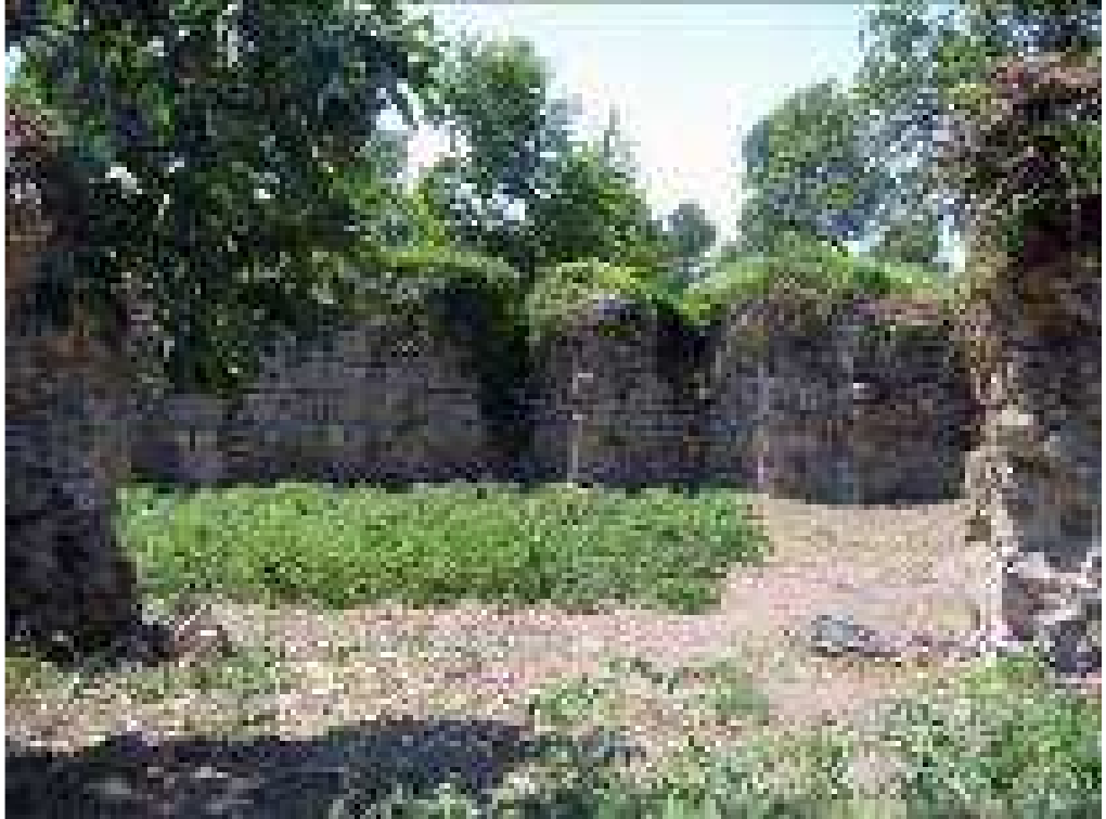
Resim 185: Birinci Altugen Kule Temizlik Sonrası İç Mekân
