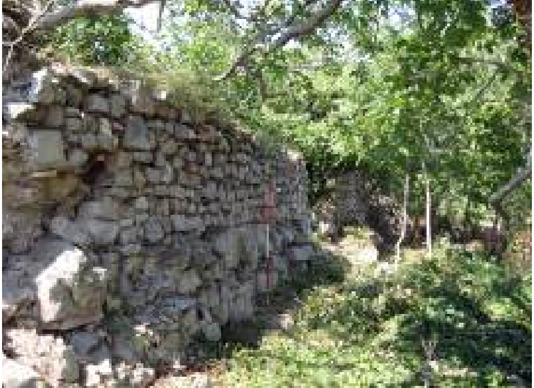
Resim 53: Güney Agora Sur Duvarından Geç Dönem Kalıntıları
