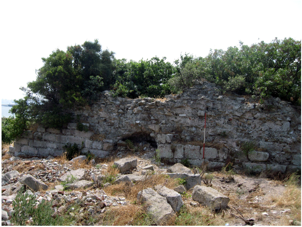
Resim 100: Demir Kapı Kuzey Yüzü
