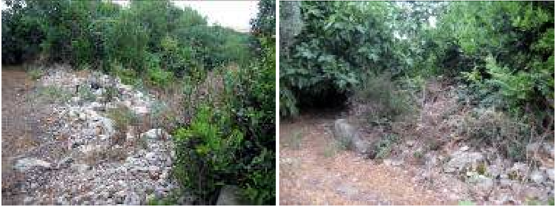
Resim 91-92: Bouleterion Surları Devamında Döküntü Halindeki Sur Kalıntısı
