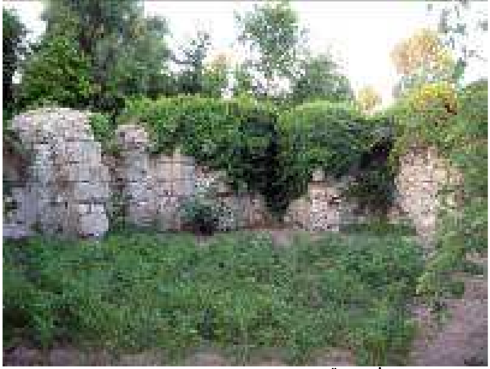
Resim 182: Birinci Altugen Kule Temizlik Öncesi İç Mekân
