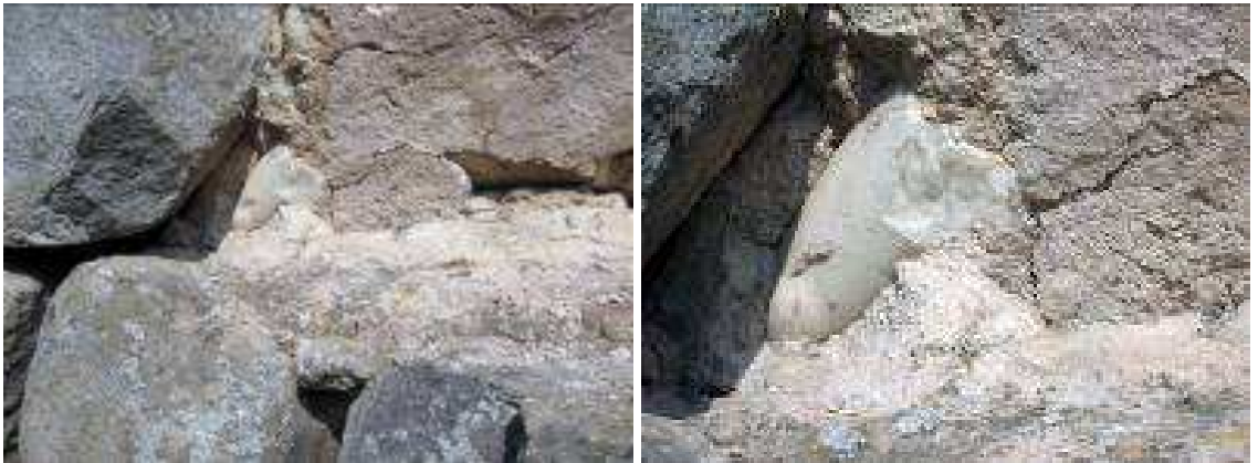
Resim 160-161: Akropol Surları Kullanılan Horasan Harcı ve Devşirme Malzeme
