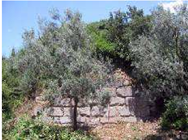
Resim 72-73: Güney Agora Devamındaki Sur Duvarının Duvar Örgüsü
