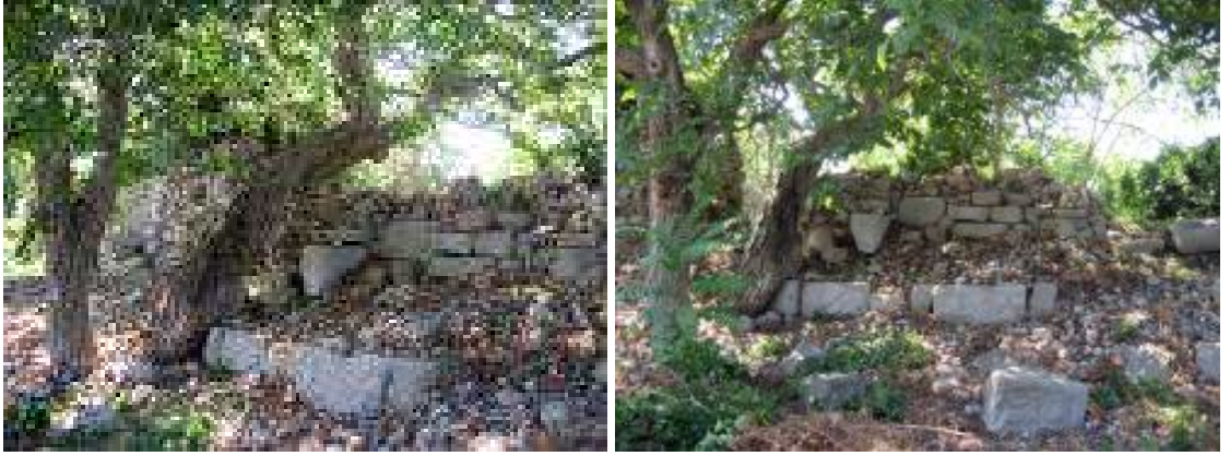
Resim 56-57: Güney Agora Sur Duvarının Döküntü Halindeki Kalıntıları
