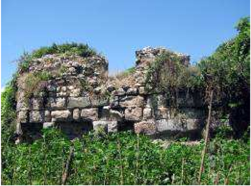
Resim 180: Birinci Altıgen Kule Duvarlarının Dıştan Görüntüsü
