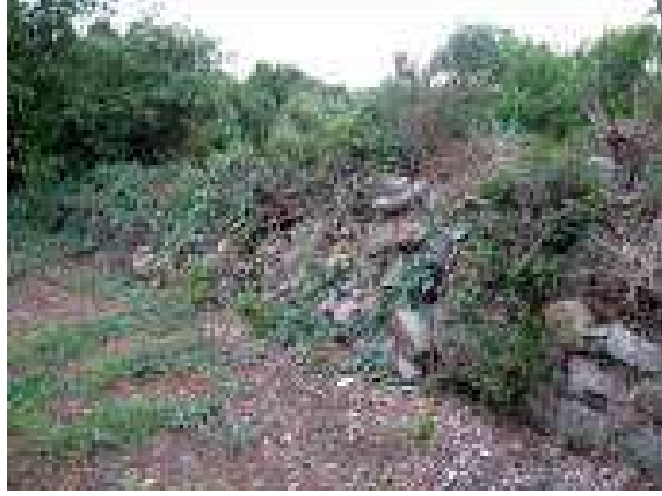
Resim 93: Bouleterion Surları Devamında Döküntü Halindeki Sur Kalıntısı
