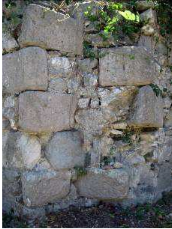
Resim 188: Birinci Altıgen Kulede Dilimlerin Bağlantıları
