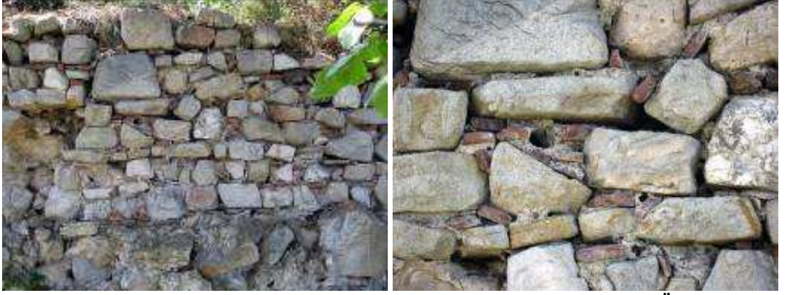
Resim 54-55: Güney Agora Sur Duvarından Geç Dönem Duvar Örgüsü
