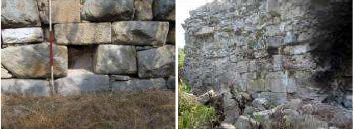
Resim 162-163: Akropol Surları Duvar Örgüsü
