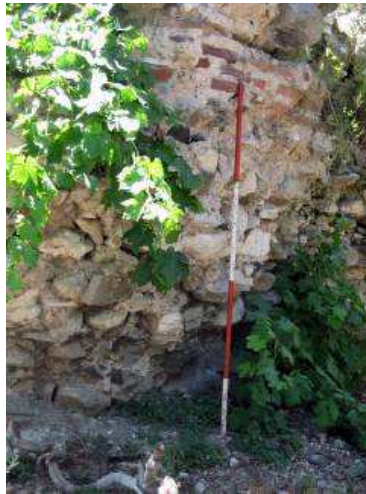
Resim 224: İkinci Altıgen Kuledeki Duvar Örgüsü ve Kullanılan Horasan Harcı
