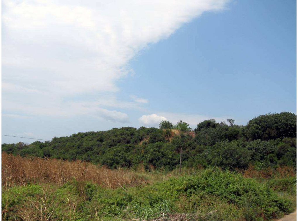
Resim 240: Panarmos Limanı'nın Bitki Örtüsü Altında Kalan Dalgakıranı
