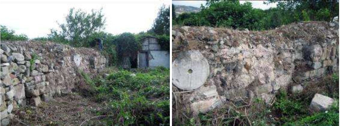
Resim 12-13: Güney Surları-Devşirme Malzeme
