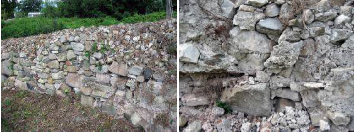
Resim 10-11: Güney Surları-Duvar Örgüsü
