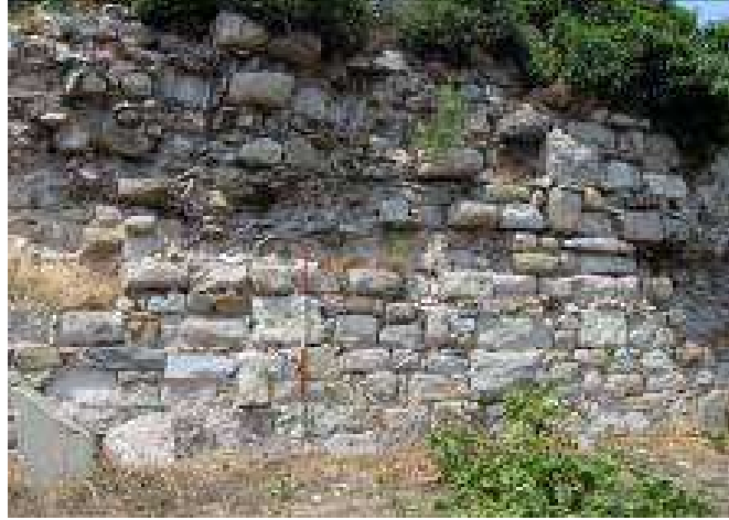
Resim 171: Tapınak Surları Duvar Örgüsü
