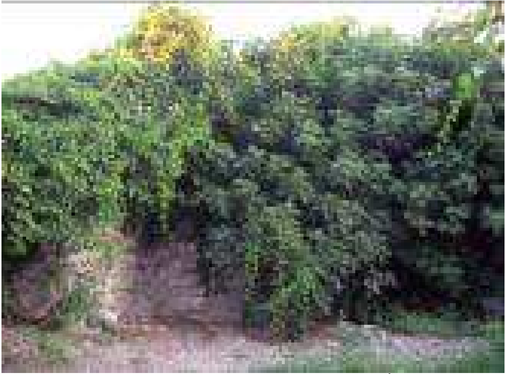
Resim 183: Birinci Altugen Kule Temizlik Öncesi İç Mekân
