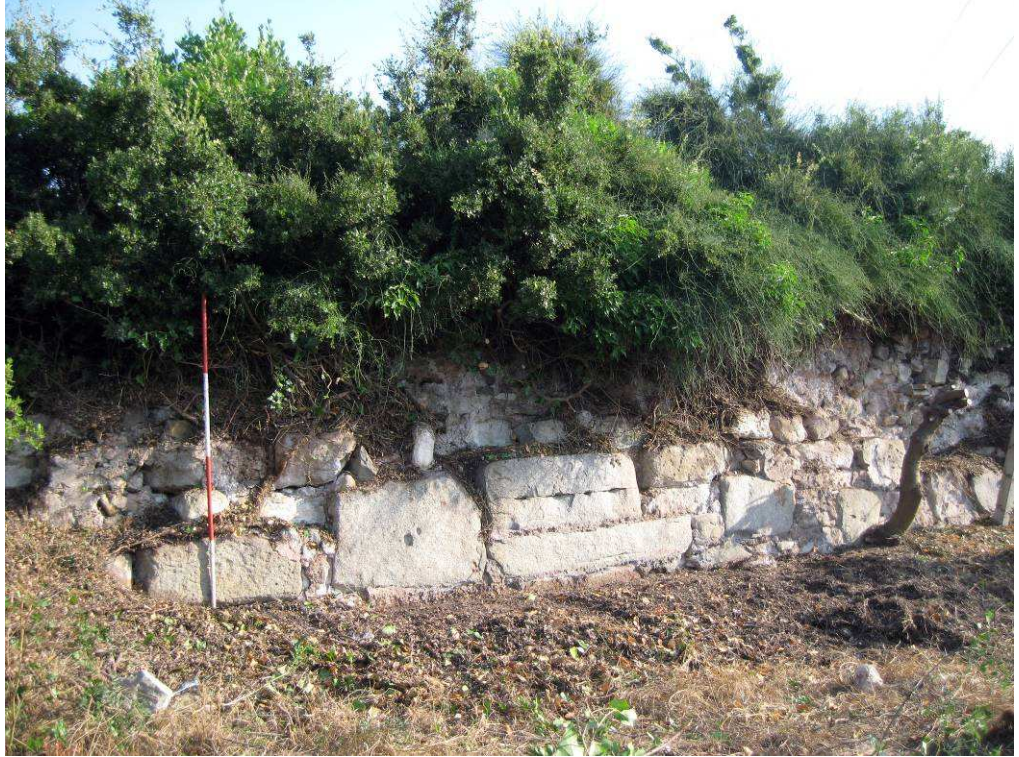
Resim 254: Thrakikos Limanı Dalgakıranında Kullanılan Blok Taşlar
