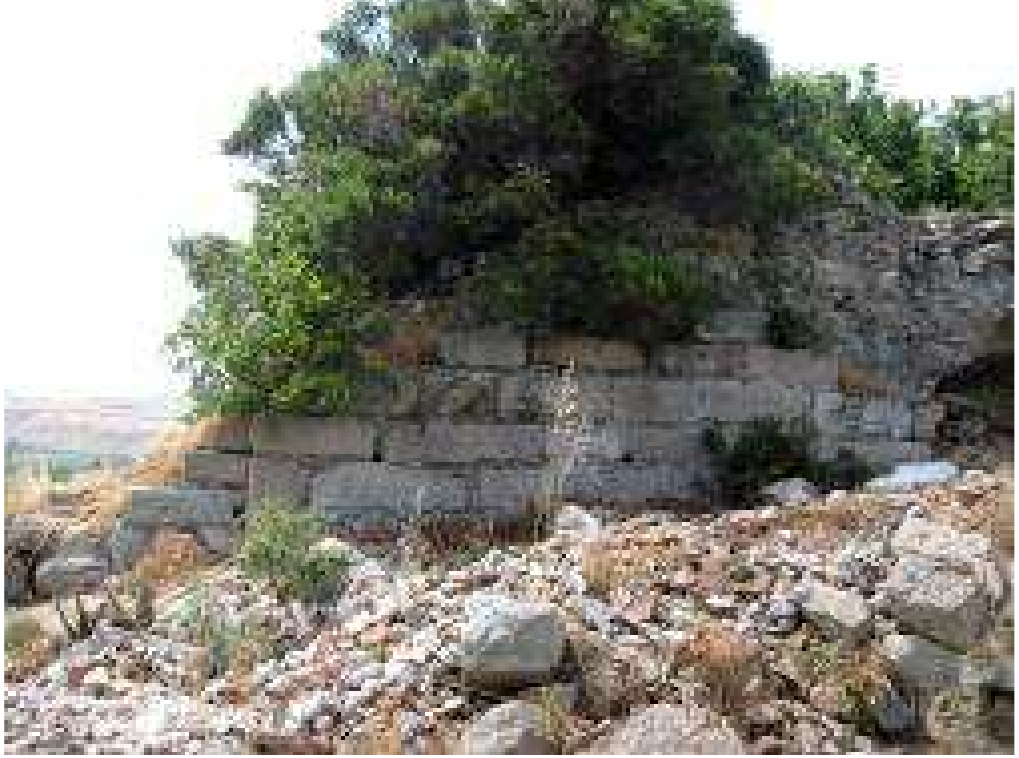
Resim 102: Demir Kapı'nın Doğu Kanadı
