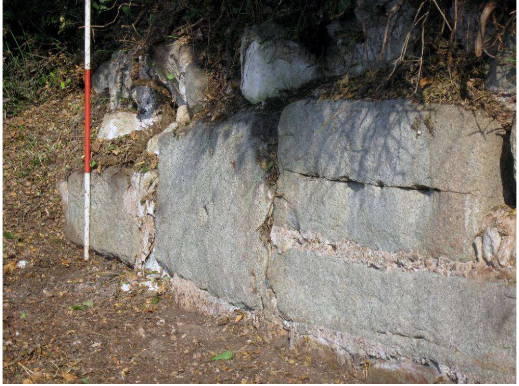
Resim 255: Thrakikos Limanı Dalgakıranında Kullanılan Horasan Harcı
