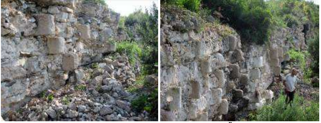
Resim 86-87: Bouleterion Surları Duvar Örgüsü
