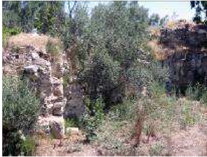
Resim 215: İkinci Altugen Kule İç Mekân
