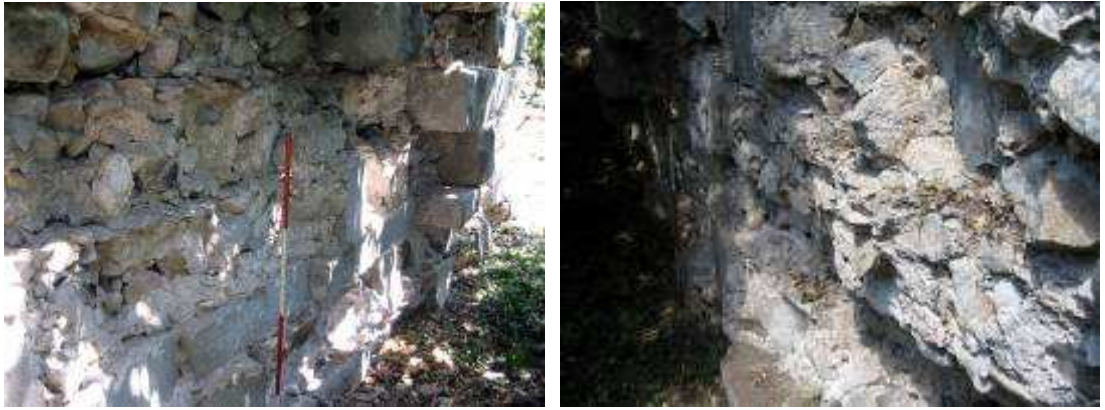
Resim 70-71: Güney Agora Devamındaki Sur Duvarında Görülen Horasan Harcı
