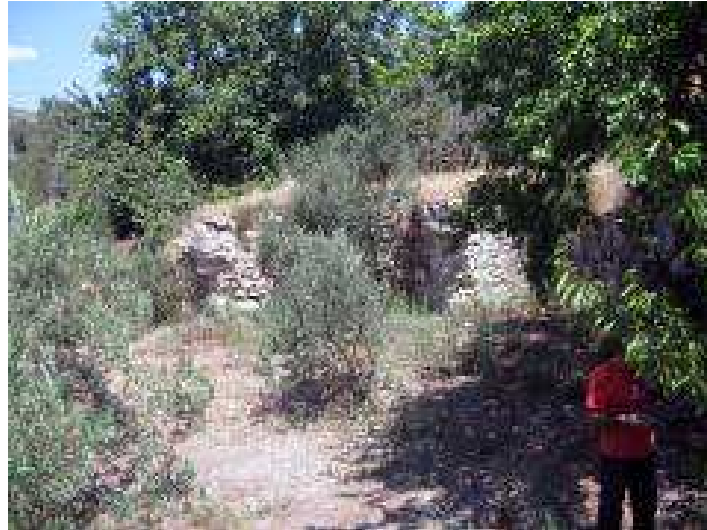
Resim 216: İkinci Altugen Kule İç Mekân
