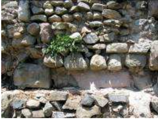
Resim 132-133: Doğu Surlarının Dördüncü Kalıntısında Duvar Örgüsü ve Kullanılan Horasan Harcı
