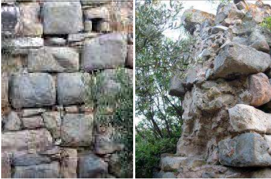
Resim 158-159: Akropol Surları Duvar Örgüsü ve Kullanılan Horasan Harcı
