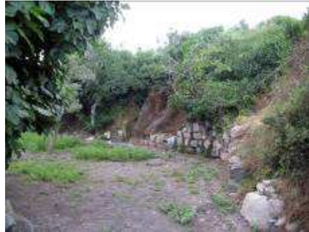
Resim 94: Bouleterion Surları Devamında Döküntü Halindeki Sur Kalıntısı
