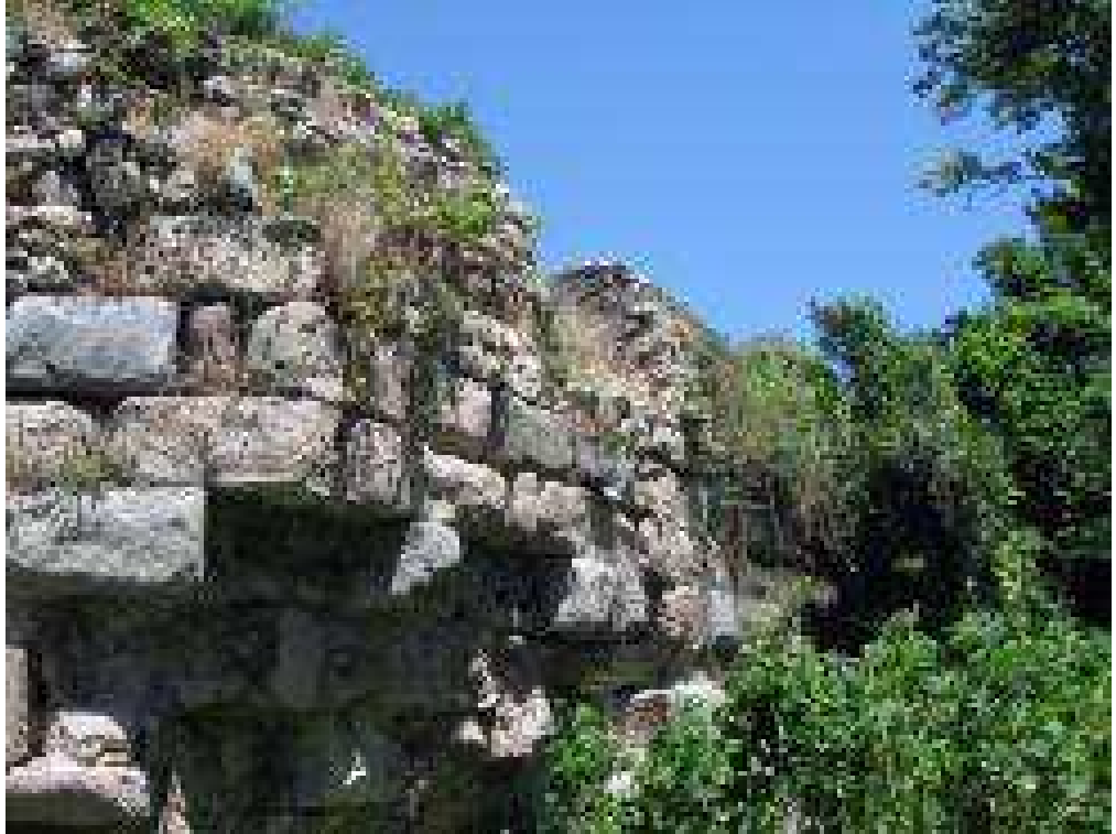
Resim 181: Birinci Altıgen Kule Duvarlarının Dıştan Görüntüsü
