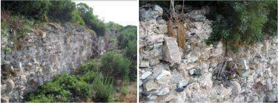
Resim 88-89: Bouleterion Surları Duvar Örgüsü
