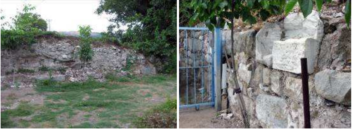
Resim 20-21: Bahçe Duvarı Olarak Kullanılan Sur
