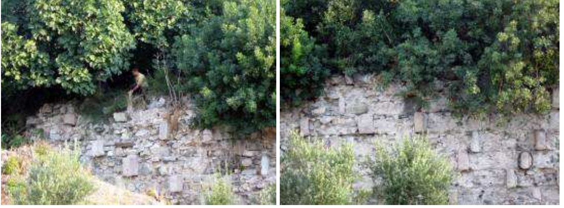
Resim 84-85: Bouleterion Surları Temizlik Çalışmaları
