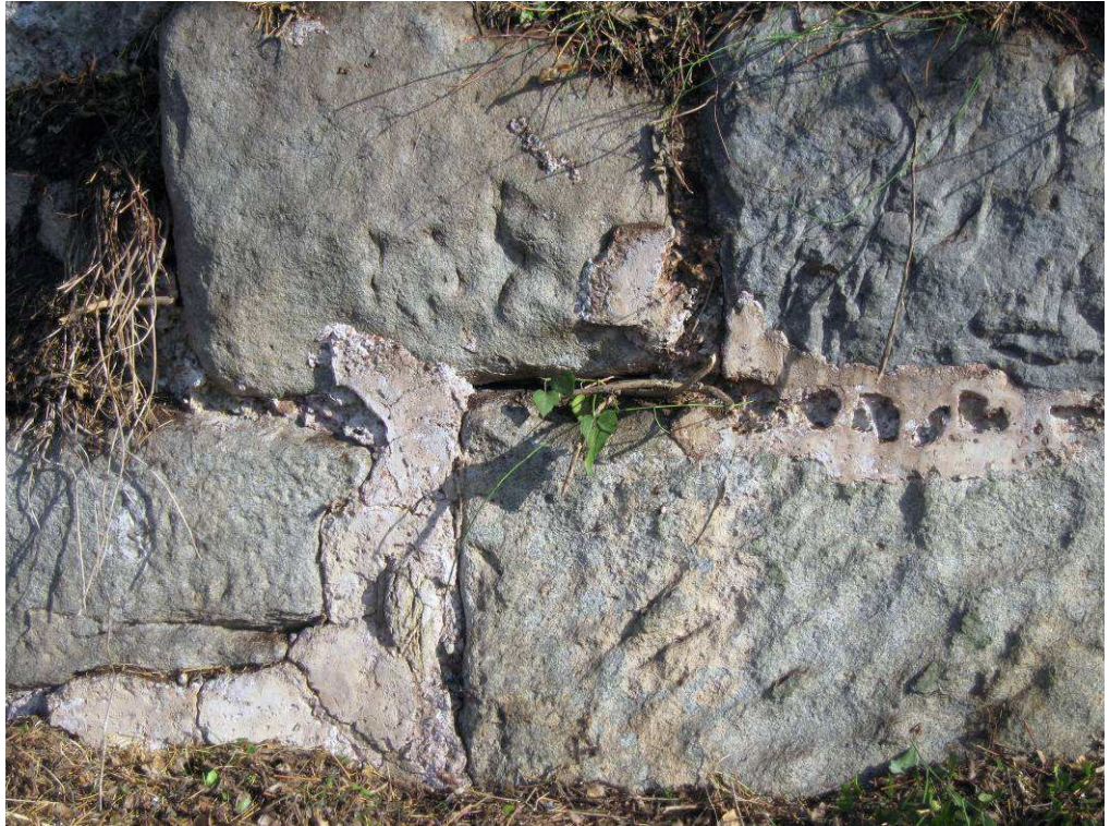
Resim 256: Thrakikos Limanı Dalgakıranında Kullanılan Horasan Harcı
