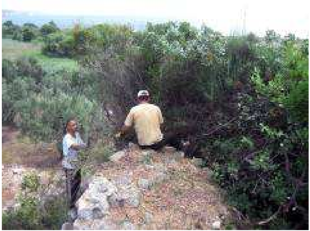
Resim 104: Demir Kapı'da Temizlik Çalışmaları
