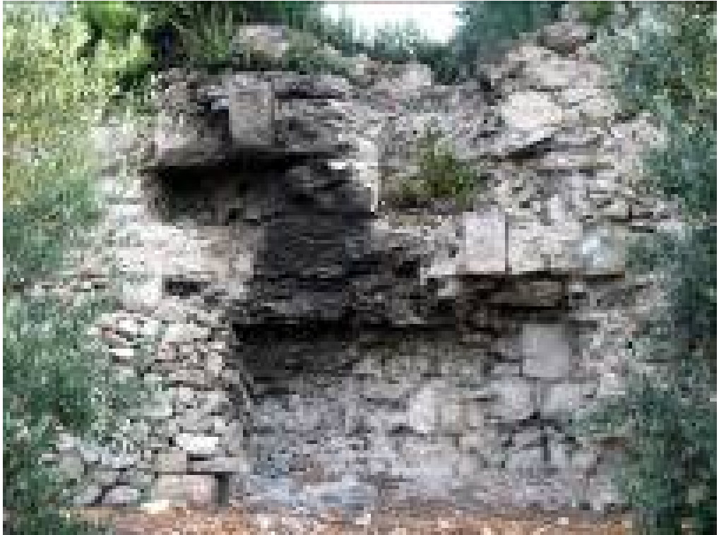
Resim 83: Bouleterion Surları Duvar Örgüsü
