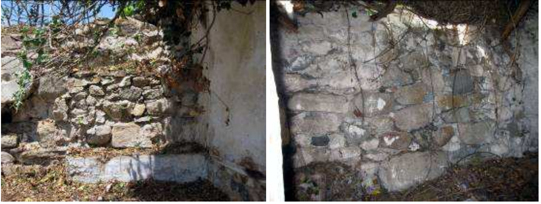
Resim 22-23: Bahçe Duvarı Olarak Kullanılan Sur
