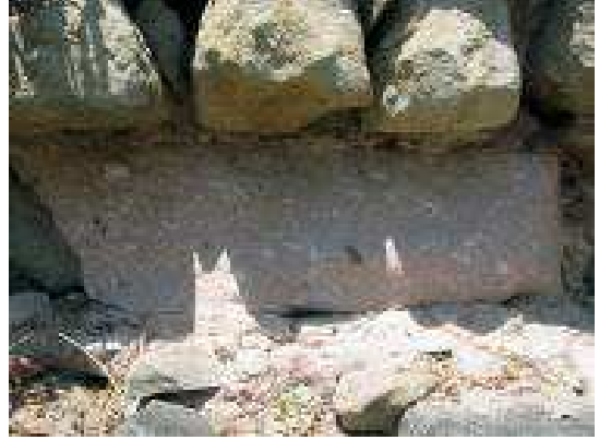
Resim 132-133: Doğu Surlarının Dördüncü Kalıntısında Duvar Örgüsü ve Kullanılan Horasan Harcı
