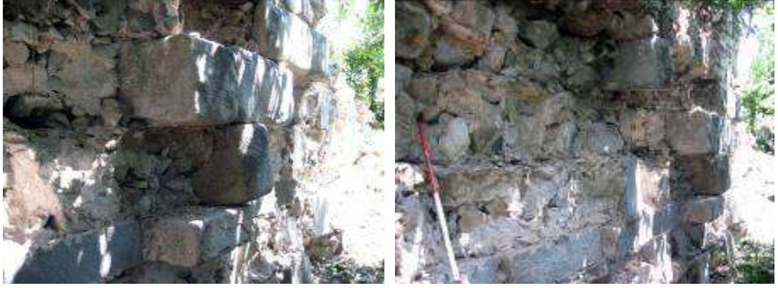
Resim 68-69: Güney Agora Devamındaki Sur Duvarında Görülen Horasan Harcı
