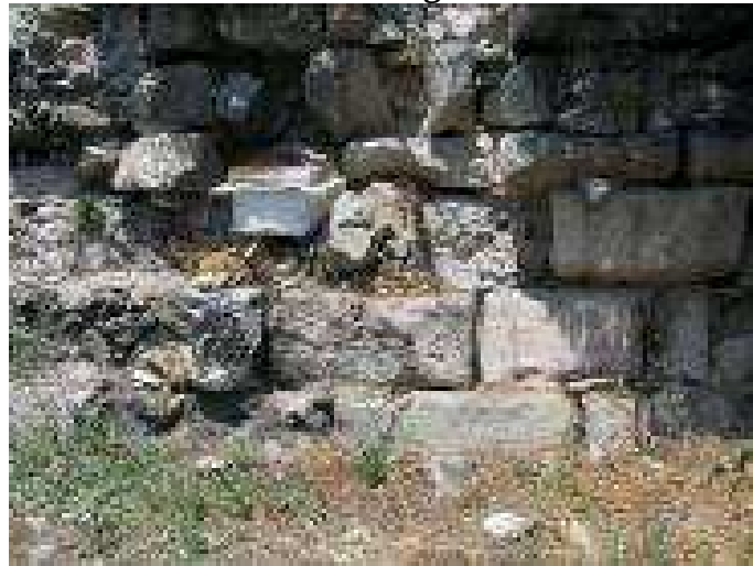
Resim 130: Doğu Surlarının Dördüncü Kalıntısında Duvar Örgüsü
