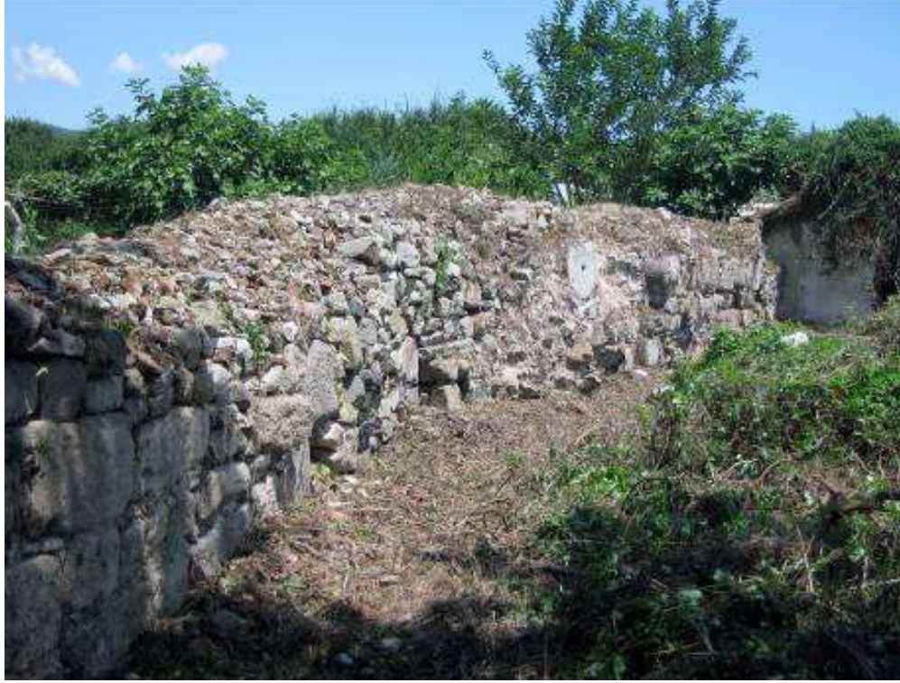
Resim 14: Güney Surları-Duvar Örgüsü
