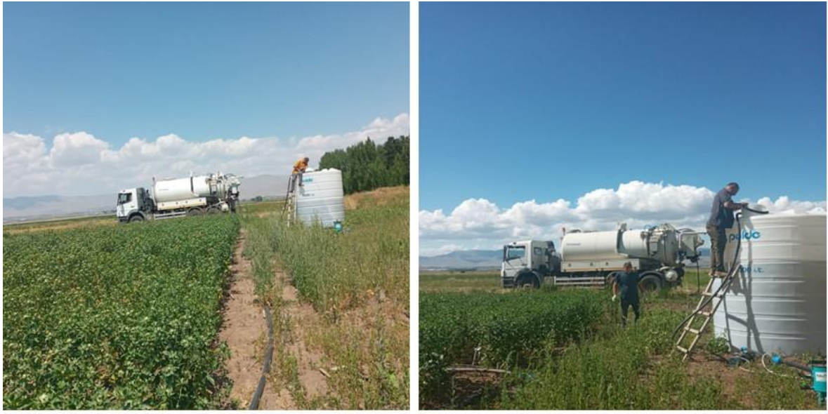
Şekil 6. Arıtılmış atık suyun deneme alanına vidanjörle taşınması ve 10 ton kapasiteli depoya aktarımı
